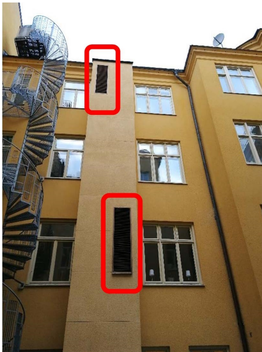
Figur 9 Uteluftsintag i fasad. Bullerbilden på gården domineras av kombihuvorna i angränsande fasad. Det var därför ej möjligt att urskilja uteluftens bidrag till totalnivån på gården. Ljudnivån bedöms däremot vara förhållandevis låg.
