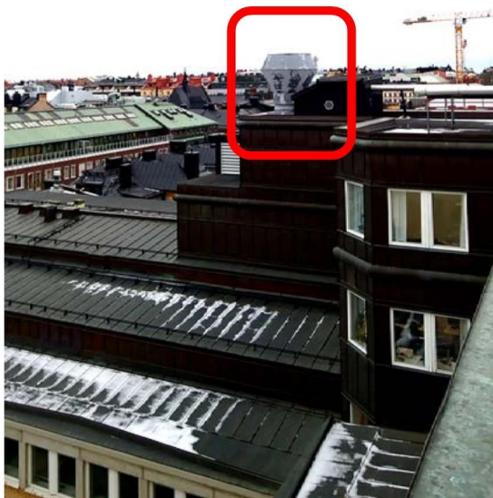
Figur 4 Avluftshus Sturegatan 4C. Denna källa rivs.
