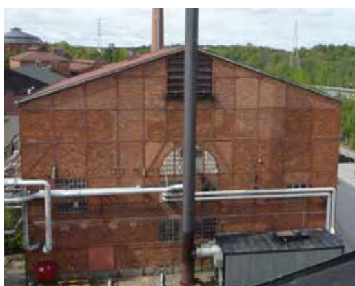
Hus 25 sett från öster omkring 2010 (Nyréns)
