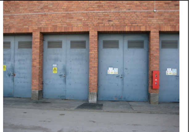
Norra fasaden, ställverk
