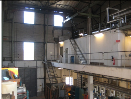
Fjärrvärmeanläggning, kontorsdel (entresol)
