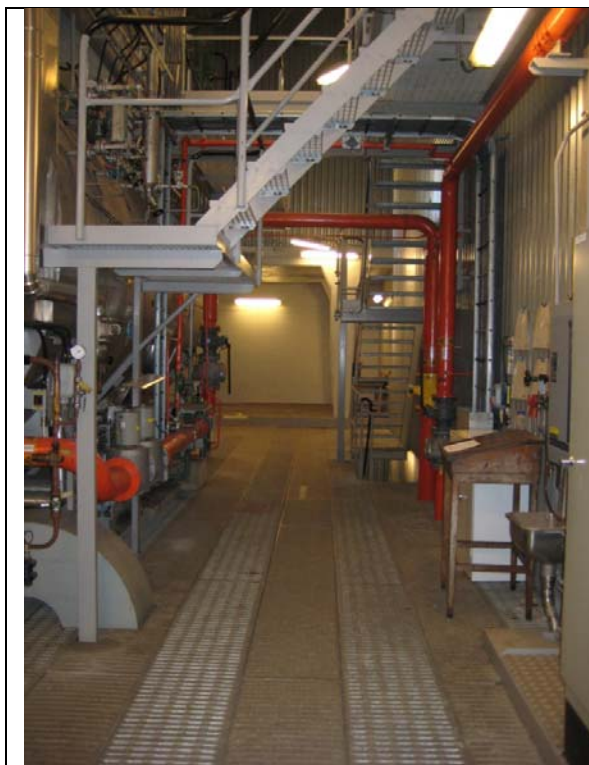
Nya installationer i norra delen
