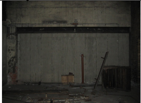
Igenmurad koksfixa i källaren mot byggnad 24
