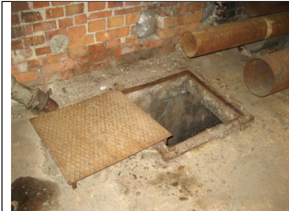
Tjärfack, sydvästra hörnet byggnad 25
