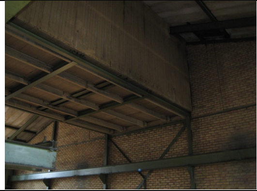
Koltransport, i taket på byggnad 25
