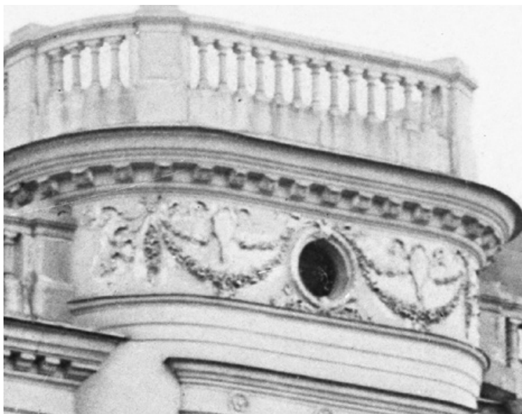
Fasadens avslut med tandsnitt och kraftig balustrad
