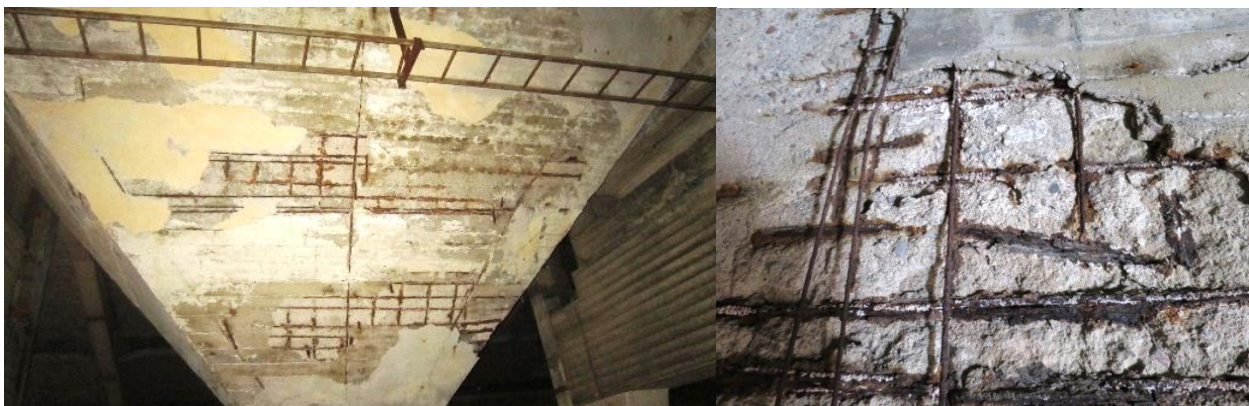
Bild 11. Kolfickor med bortrostad armering. F33 till höger.
