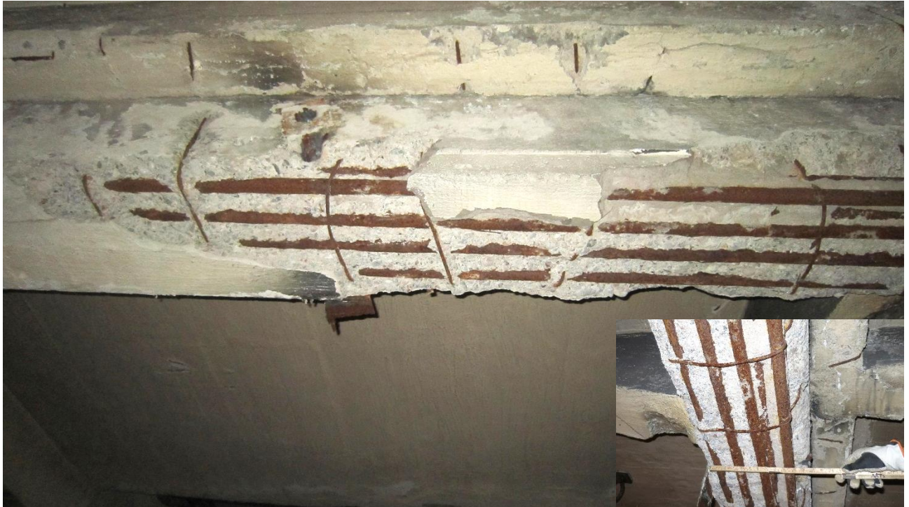
Bild 10. Primärbalk T1 med frilagd armering: 4+4Ø28, byglar Ø6 s ≈ 350.
