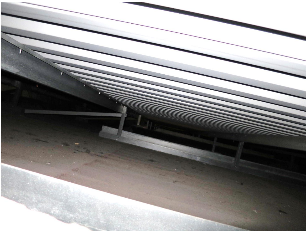
Bild 8. Nyare yttertak av plåt uppstolpat mot betongtakets pappklädda yta.
