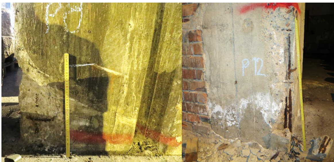
Bild 3. Spjälkskadade fyrkantiga pelare, P8 till vänster respektive väggpelare P12 till höger.
