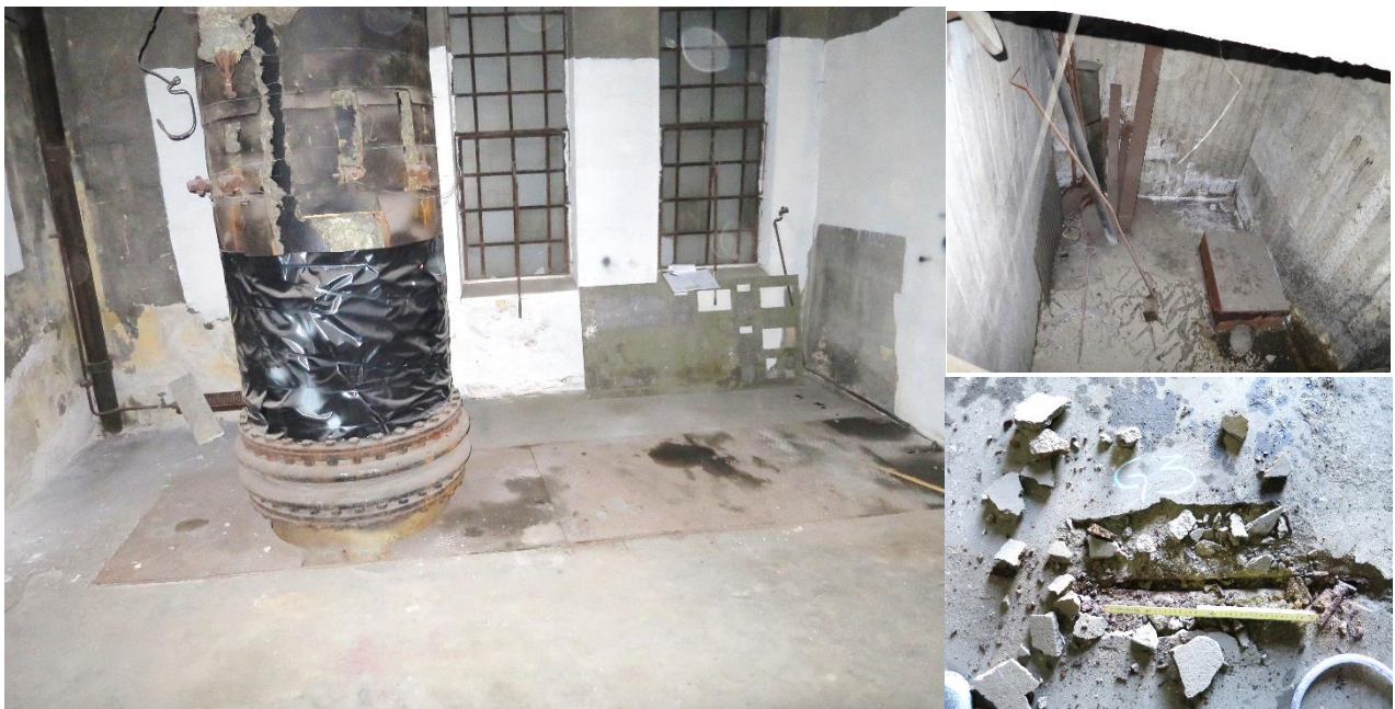
Bild 5. Rum 7A, översikt, källare respektive spjälkskada i golv (provplats G3).
