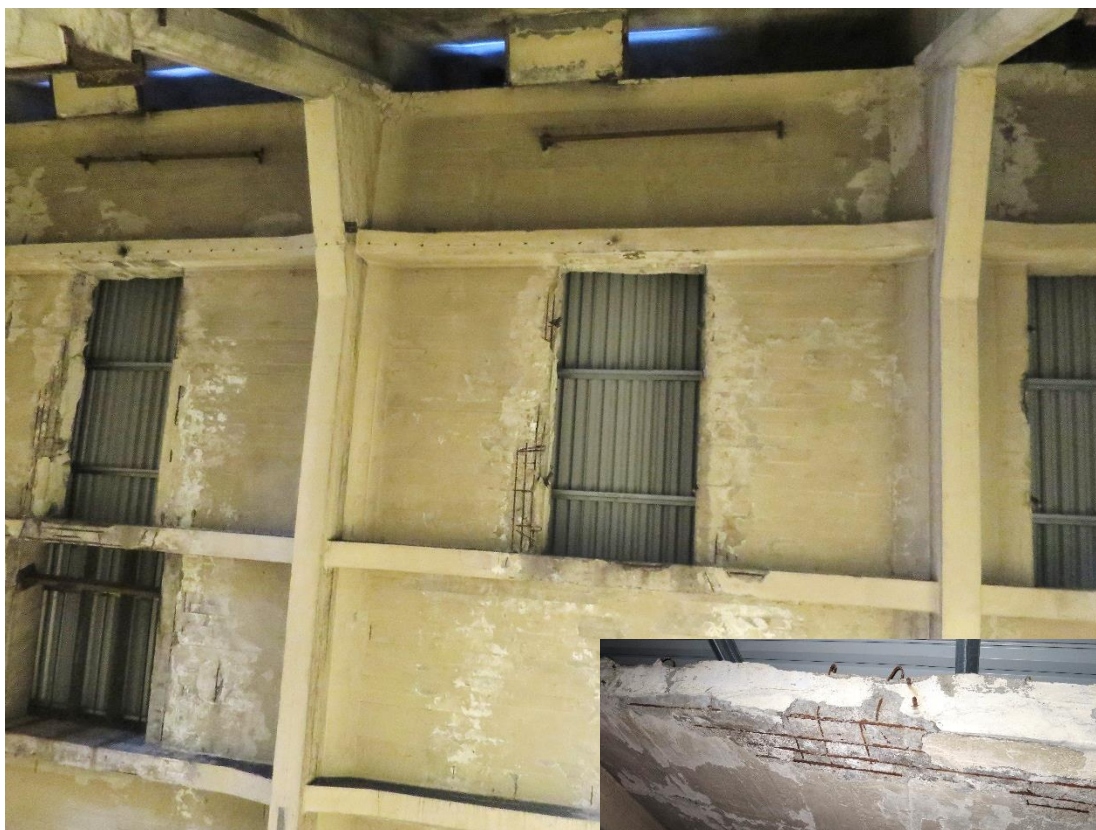
Bild 9. Frilagd armering kring hål i tak.
