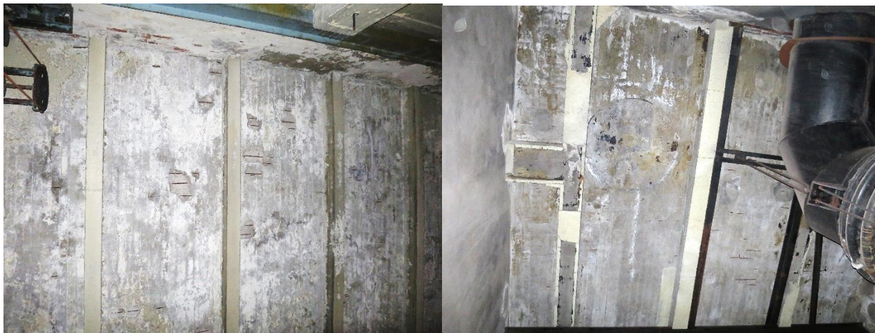
Bild 6. Spjälk- och fuktskador i tak rum 7B (vänster) och rum 7A (höger).
