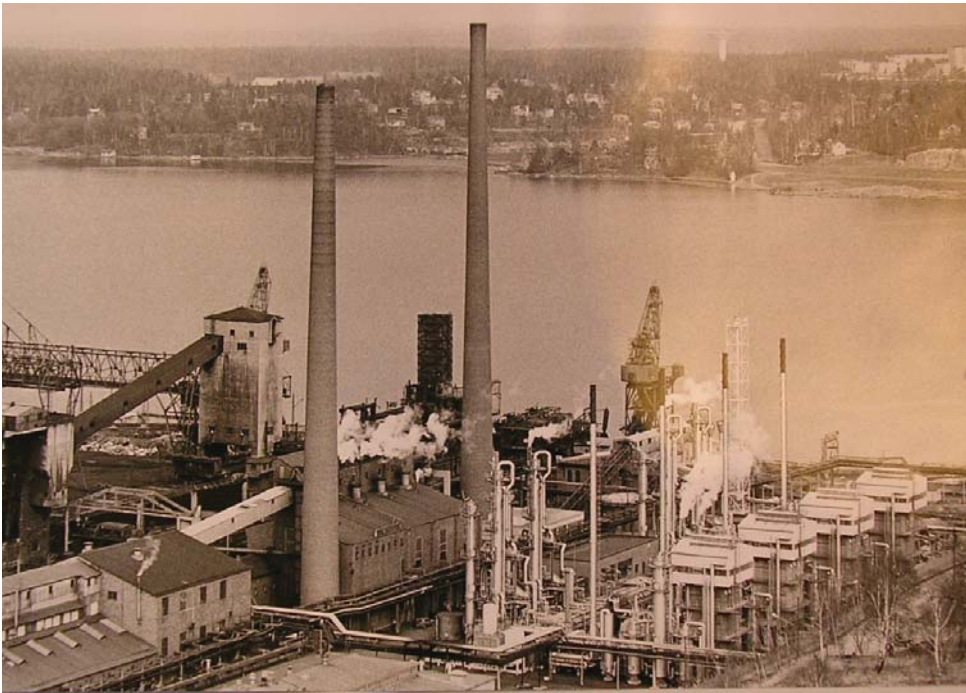
Spaltgasverket under tidigt 1970-tal. Till vänster i bild syns den numera rivna kammarugnen. Källa: Gasverkets museum.
