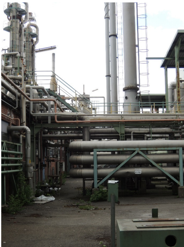
Rören vid skorstenen.
