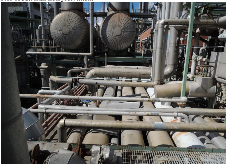
Närbild på rör på envåningsbyggnaden.
