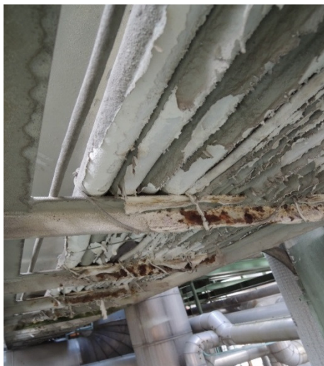
Skadade ledningar.
