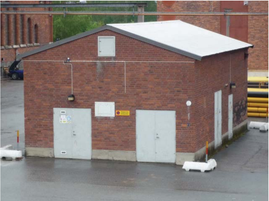
1-3 Transformatorstationen anknyter materialmässigt till den övriga anläggningen.
