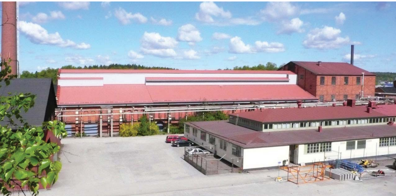
15 Retorthusets gavelfasad åt väster med skorstenen. 16 Retorthusets norra fasad med tillbyggnad i en våning från 1918 då huset byggdes om för att betjäna de nya kammarugnarna med generatorgas. 17 Retorthus I och III sedda från Gasverkssvägen i söder.
