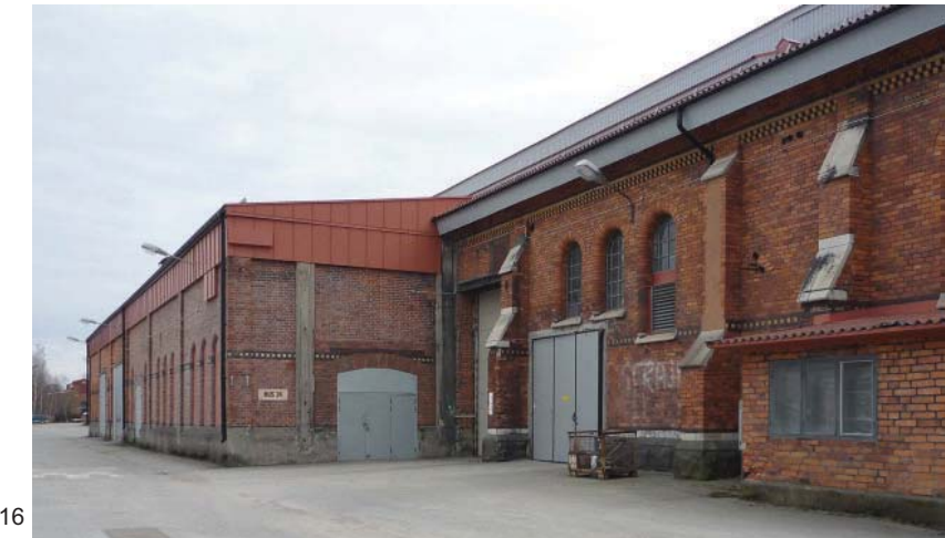
15 Retorthusets gavelfasad åt väster med skorstenen. 16 Retorthusets norra fasad med tillbyggnad i en våning från 1918 då huset byggdes om för att betjäna de nya kammarugnarna med generatorgas. 17 Retorthus I och III sedda från Gasverkssvägen i söder.
