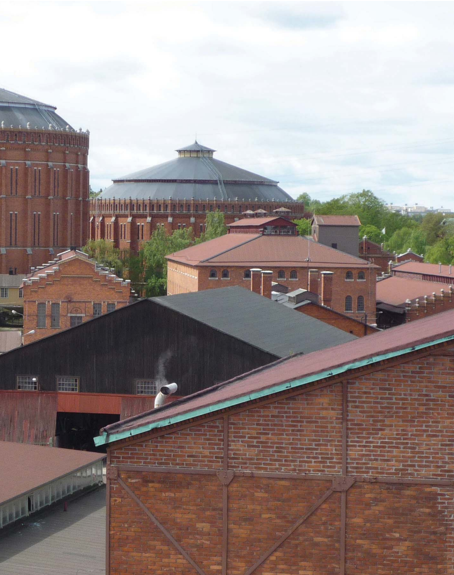
1 Vy mot sydväst över gasverksområdets inre delar.
