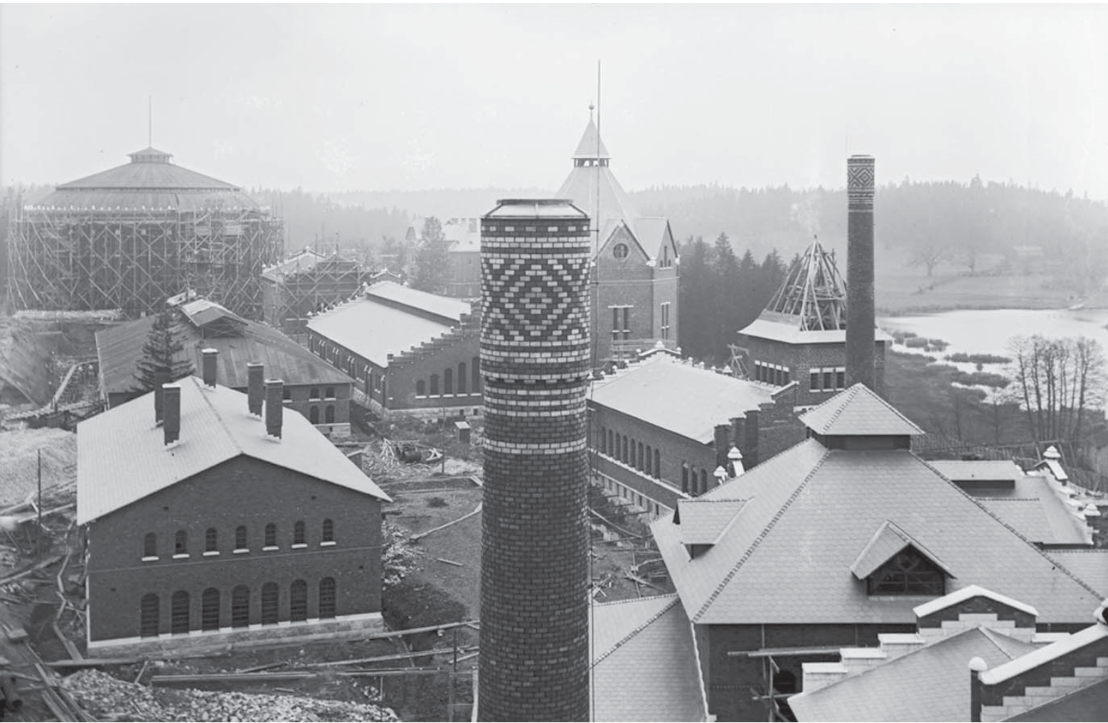
1 Foto från öster, Karl Severin Eklund, cirka 1892. Copyright Peter Nyblom. 2 Den nybyggda Gasklocka IV. Foto Oscar Bladh 1932. Källa: SSM.
