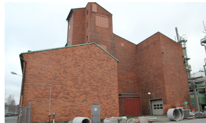
Bild 84: Fasad mot sydost.
