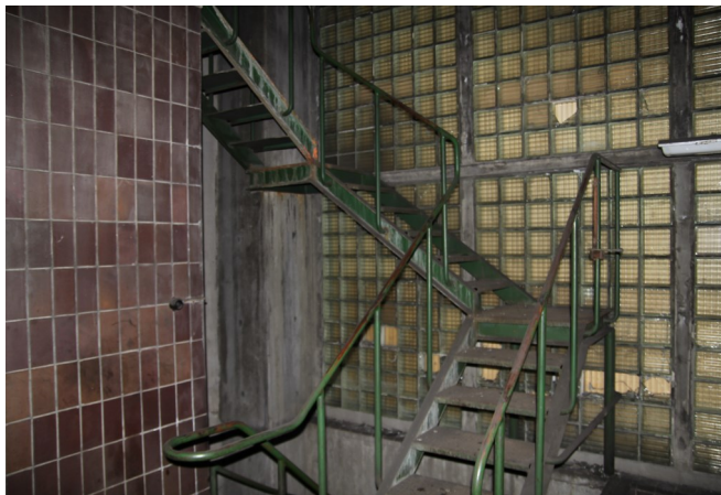
Bild 93: Gjutjärnstrappa i ångpannerummet.
