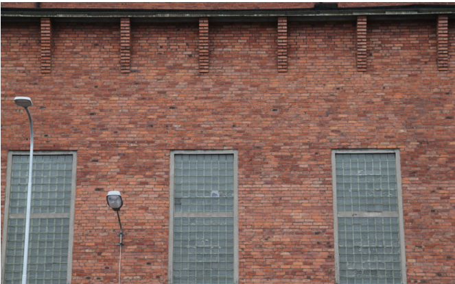
Bild 88: De sågtandade takfötterna är symmetriskt placerade, under fönster med betongglas.
