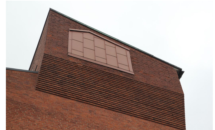
Bild 87: Sågtandad murning även under den utskjutande högdelen.
