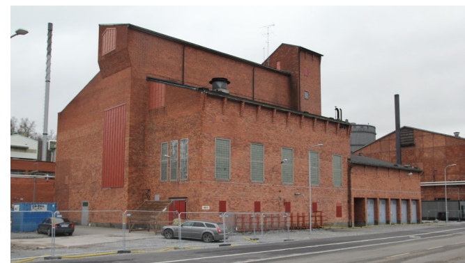
Bild 85: Fasad mot nordväst.
