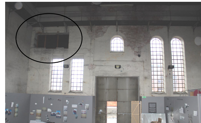
Bild 24: Interiört fotografi av fasad mot sydväst, visar upptagning för gas.
