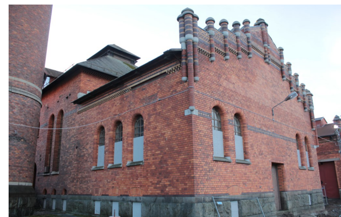
Bild 52: Byggnadens norra del.
