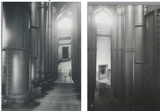
Bild 13-14: Kondensatorerna. Höger bild sett tagen åt söder, vänster bild tagen åt norr, samma riktning som vänstra ritningen ovan. Källa: SSM.
