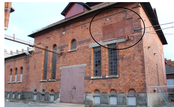
Bild 25: Exteriört fotografi av fasad mot sydväst, visar upptagning för gas.
