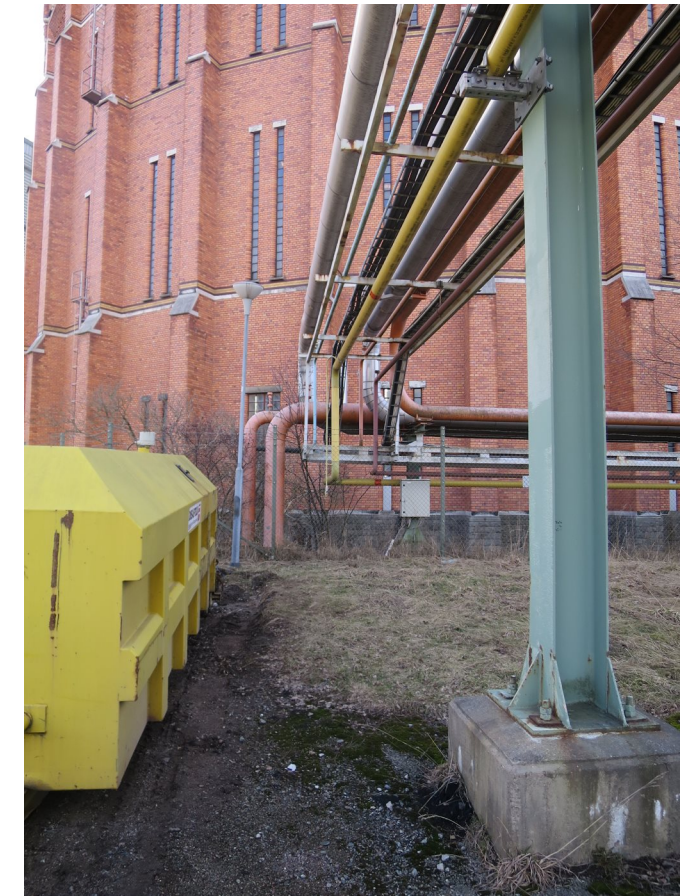
Vy 23. Södra ledningsstråket vid gasklocka 2.
