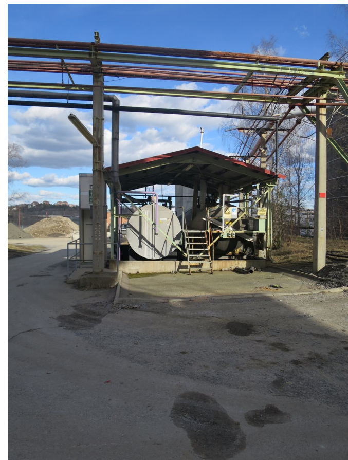
Vy 34. Södra ledningsstråket åt öster.
