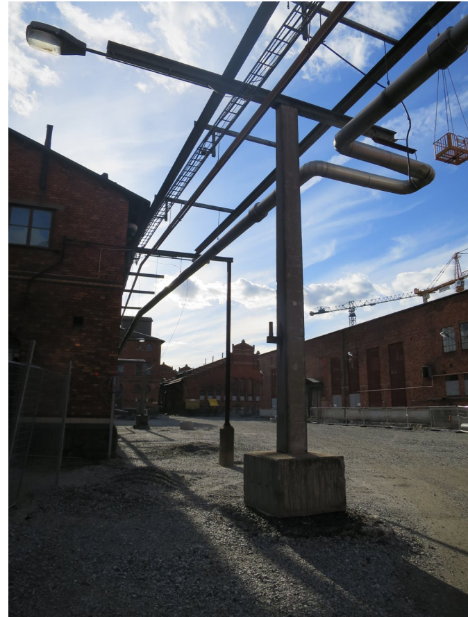
Vy 9. Två av tre kraftigare stolpar, till sin utformning, avvikande från de ursprungliga smäckra stolparna.
