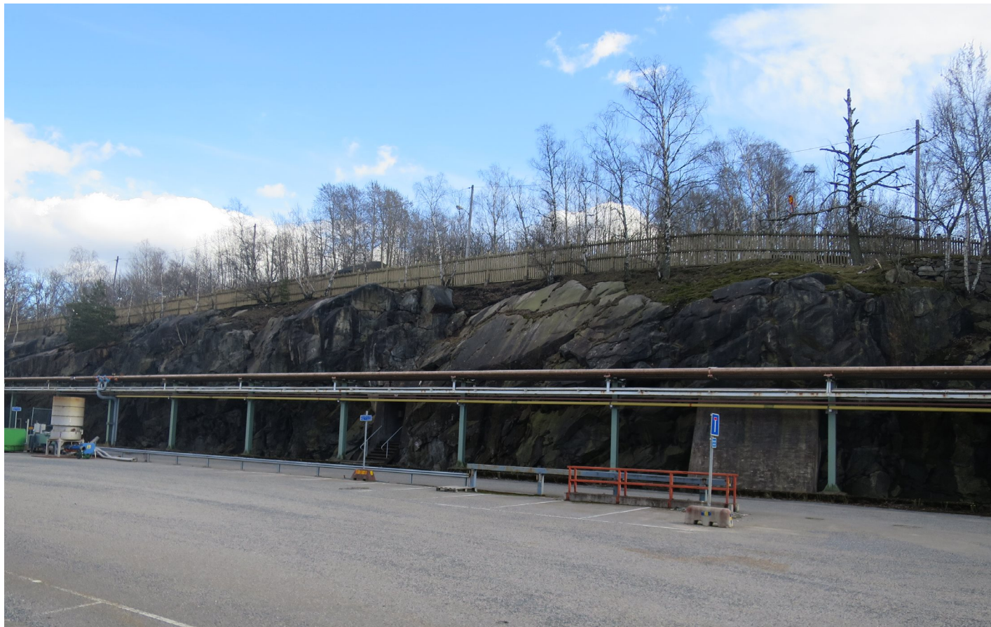
Vy 31. Södra ledningsstråket längs bergsskärningen.
