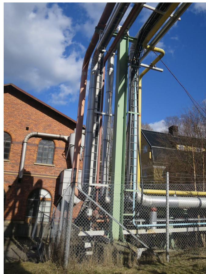
Vy 28. Södra ledningsstråket vid hus 13.
