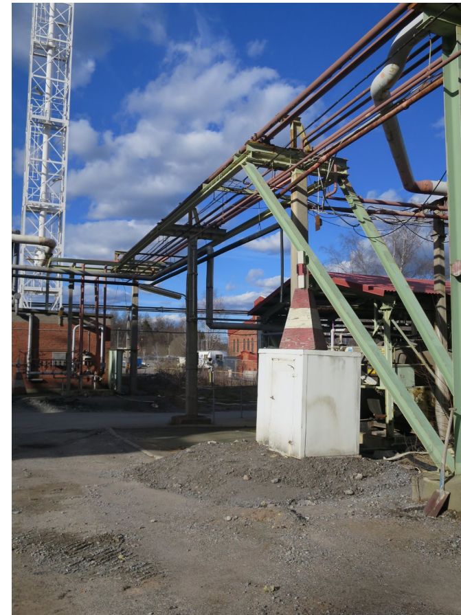
Vy 35. Södra ledningsstråket åt öster.
