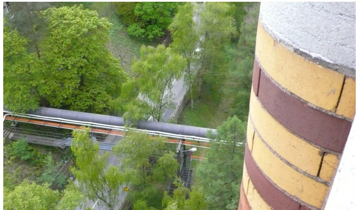
Vy 46. Gasledningen med gångbrygga över Gasverksvägen.
