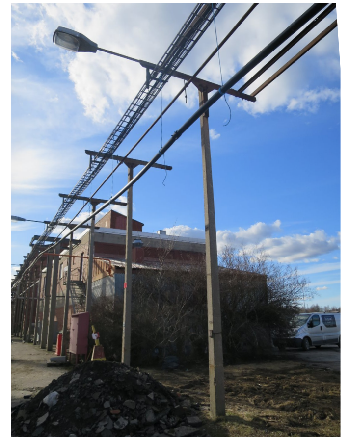
Vy 19. Norra ledningsstråket i östra änden.
