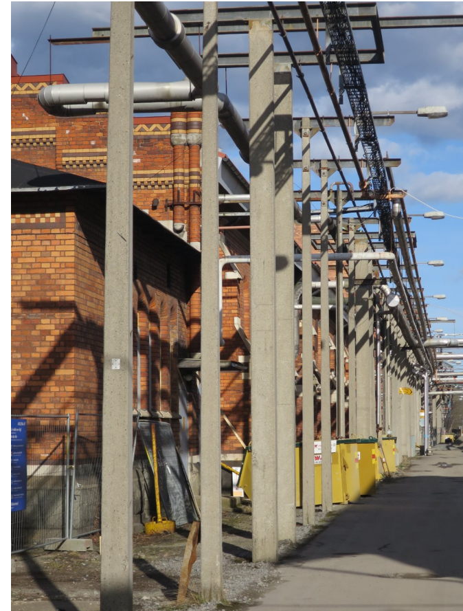
Vy 10. Norra ledningsstråket längs Retorthuset 24, 26 österut med sin täta stolplacering.
