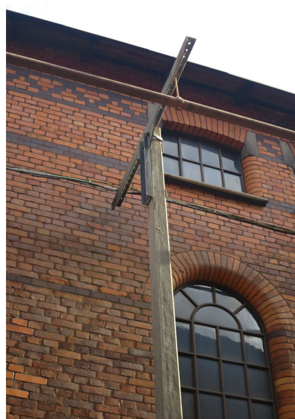
Vy 3. Betongstolpe med konsol och ledning.
