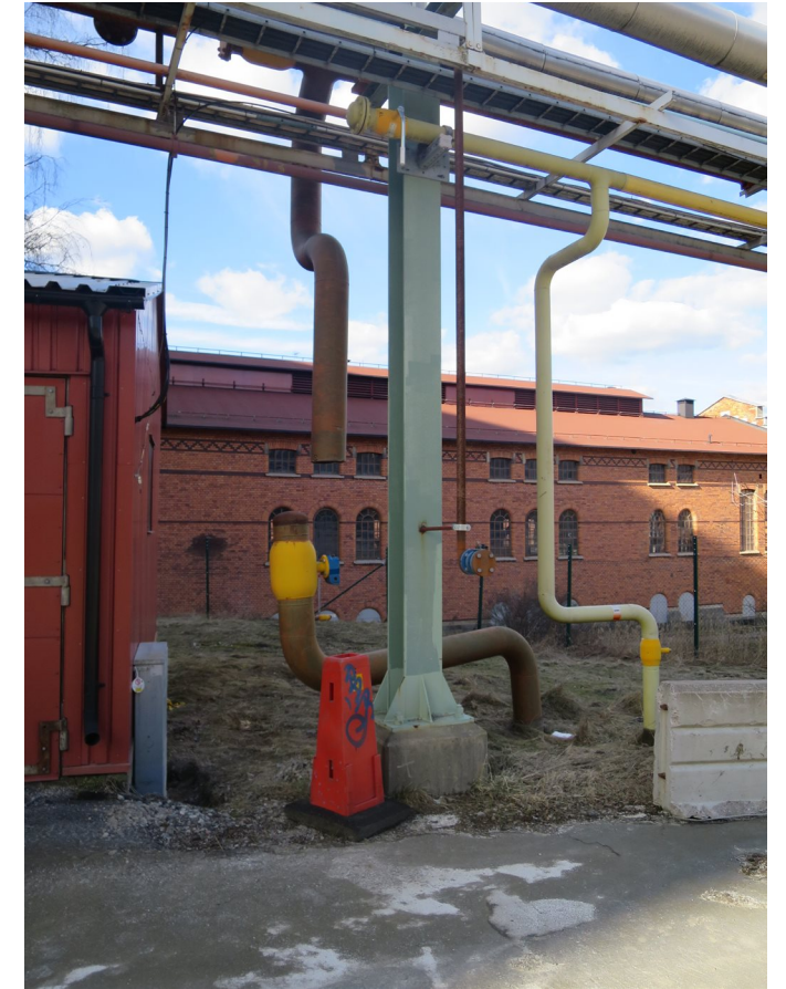
Vy 26. Södra ledningsstråket söder om hus 10.
