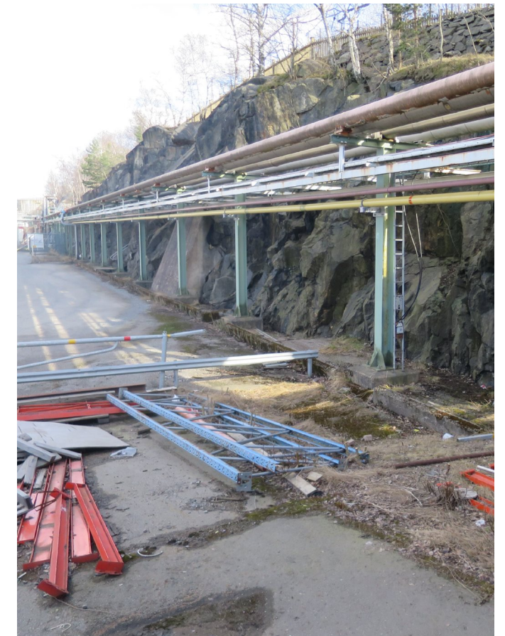
Vy 30. Södra ledningsstråket längs bergsskärningen.
