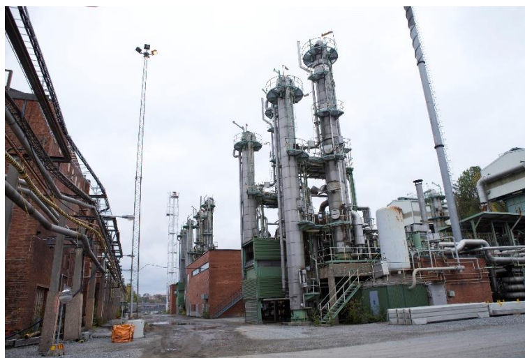
Spaltgasverket sett från väster 2016 (SBK)
