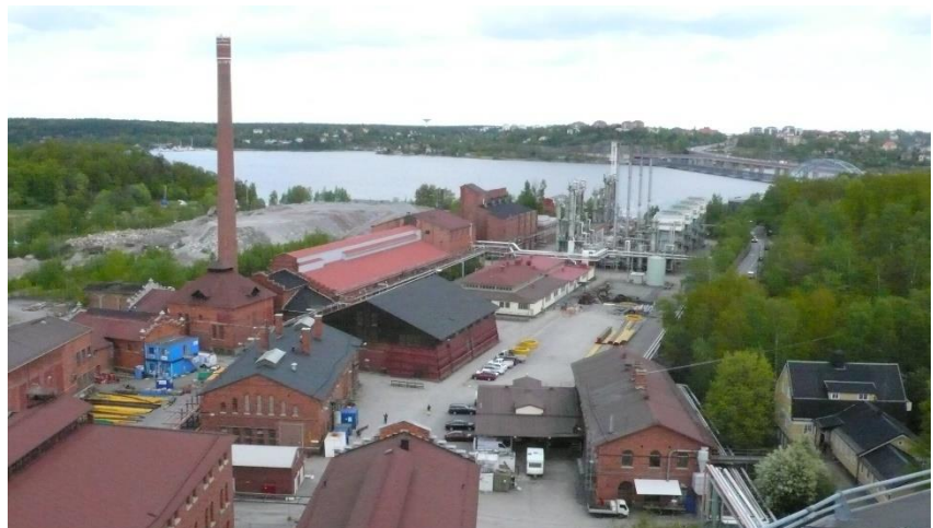
Gasverket sett från väster 2010 (Nyréns)
