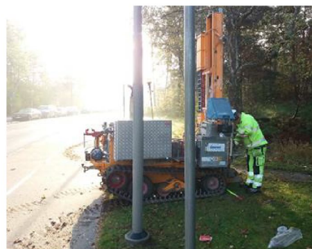
Figur 5: Borrning vid provpunkt 6.
