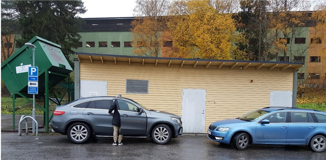
Figur 8: Byggnad som innehåller utrymme tillhörande Ellevio (vänstra dörren), förråd (mitten dörren) och Circle K's spillvattenpumpar (högra dörren).
