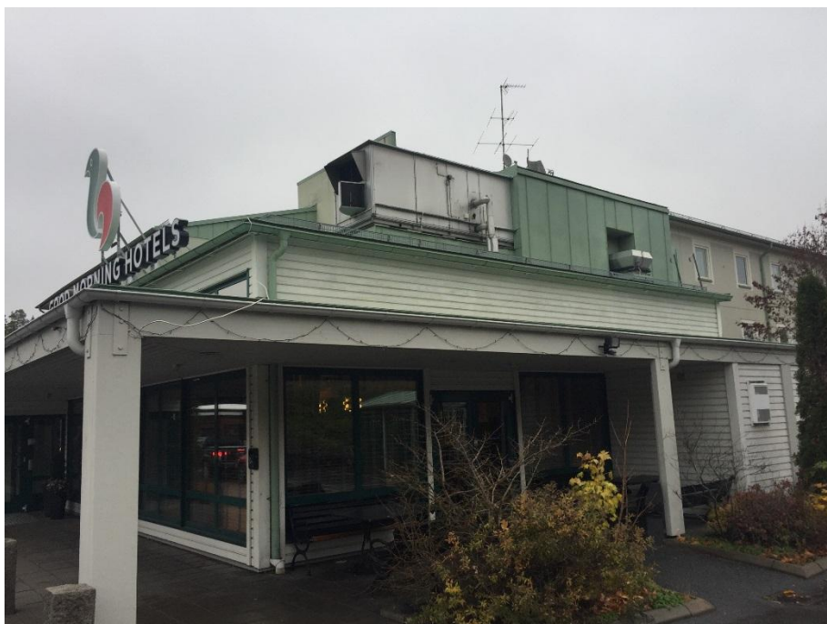
Figur 6. Fläktaggregatet över hotellets kök. Denna installation avger så pass höga ljudnivåer att man kan mäta en viss skillnad i ljudnivå trots bakgrundsnivån från trafiken. Buller från hotellet kommer inte påverka skolgården, men lite buller påverkar skolans fasader som vetter år detta håll.
