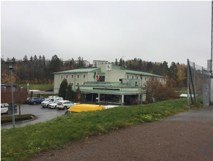
Figur 5. Good Morning Hotels har mindre fläktar på taket och ett större aggregat ovanför köket.
