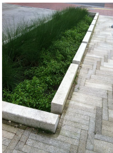
Figur 16. Nedsänkt regnbädd med släpp i kantsten.
