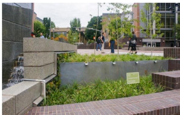
Figur 18. Regnbädd med bräddande dämme.
