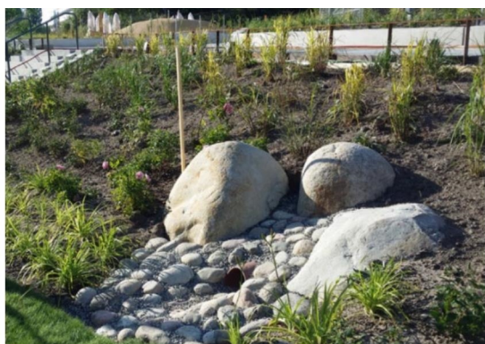
Figur 17. Nedsänkt regnbädd med utloppsledning.
