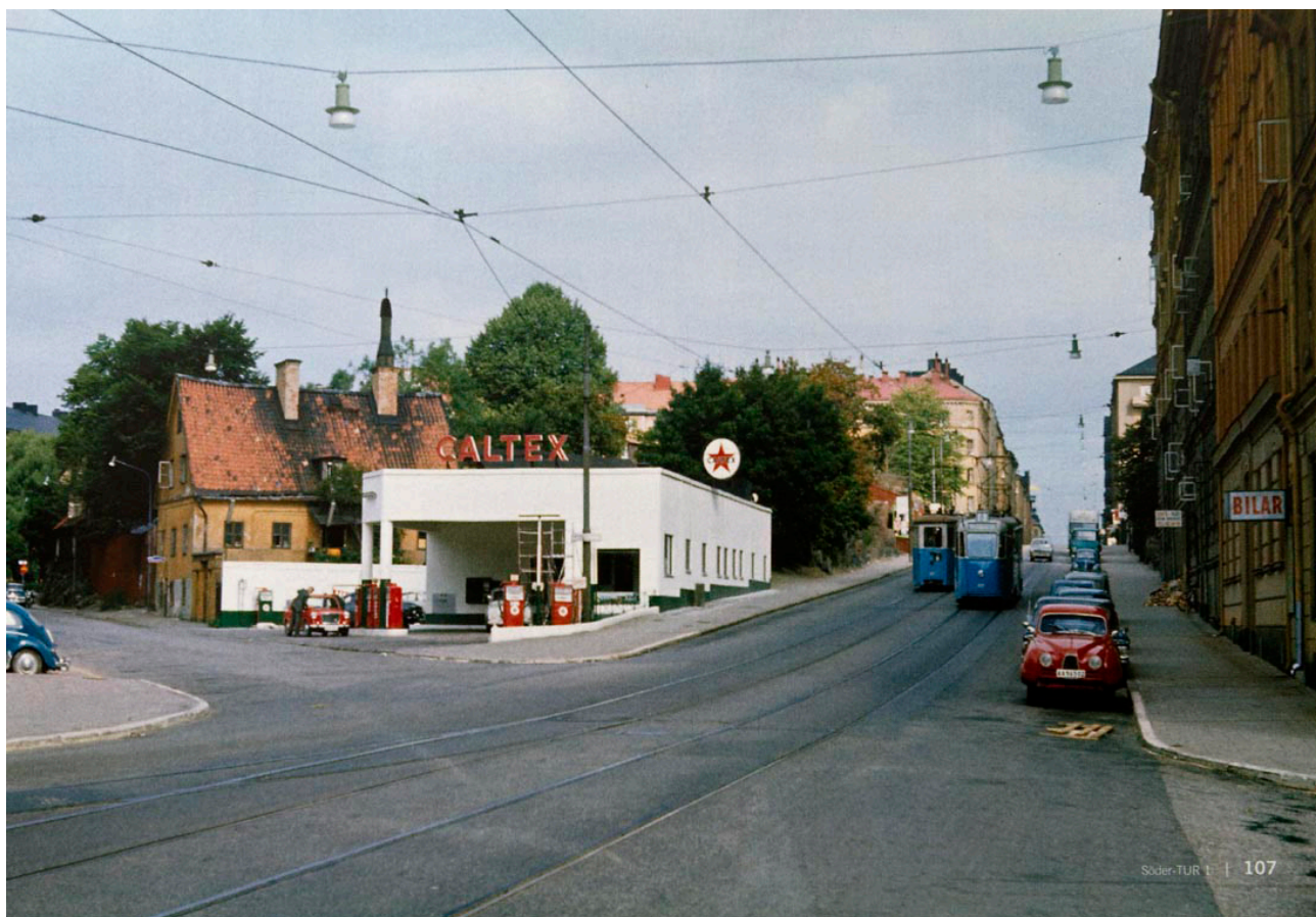
Renstiernas gata från korsningen Malmgårdsvägen år 1966. Bensinmacken Caltex ligger kvar på platsen för nuvarande Malongenparken. 1700-talshuset i tidigare kvarteret Briljanten finns kvar bakom bensinmacken. Spårvagnar trafikerar Renstiernas gata. Malmgårdsvägen har sin gamla sträckning som korsar Renstiernas gata.
