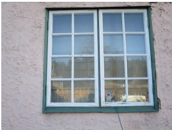
Småspröjsat fönster med handblåst glas och nätta bleck.
