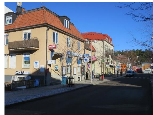
Vid Värsta allé har de äldre affärshusen på 1990-talet inspirerat till ett nybygge som lånar stildrag från sina grannar.
