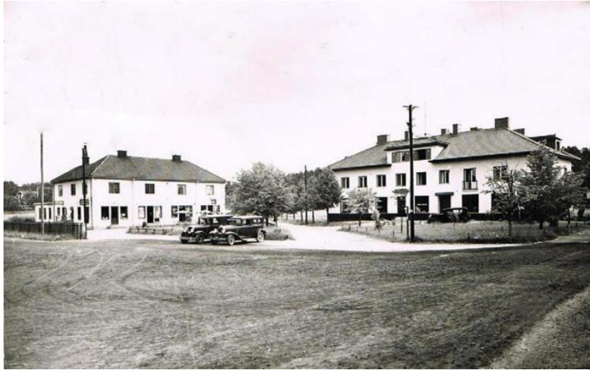
"Gula Faran" i Kv. Faste (1921, idag rivet) till vänster i bild det första huset som uppfördes i Spånga centrum. I Faste inrymdes järnhandeln i något år innan den flyttades till kv. Hedvig. Till höger i bilden ser vi Ulf 2, här fanns apotek och sjukvårdsinrättning fram till 1955 då huset ändrade funktion till stadsbibliotek, vilket det är än idag.
