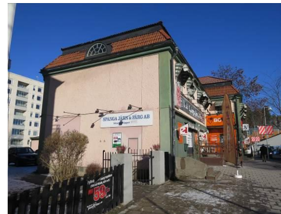
Södra gaveln är fönsterlös men i nedre takfallet sitter ett ursprungligt lunettfönster.
