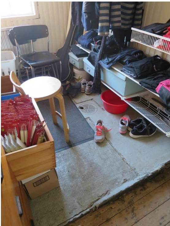
Det ursprungliga badrummet på 1 tr är rivet men golvet är bevarat.
