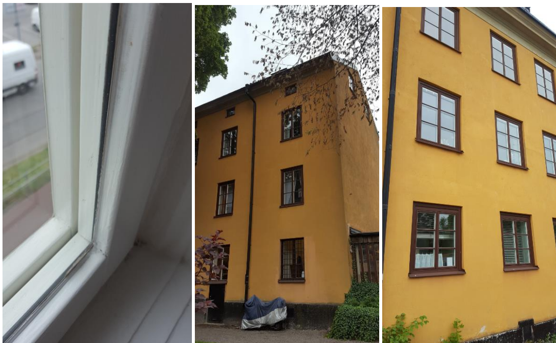
Figur 7. Närbild på fönsterkonstruktion och bild på fasad sett från innergård och från Falkenbergsgatan.
