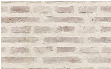
Ytterväggar bottenvåning: ljust tegel säckskurat
