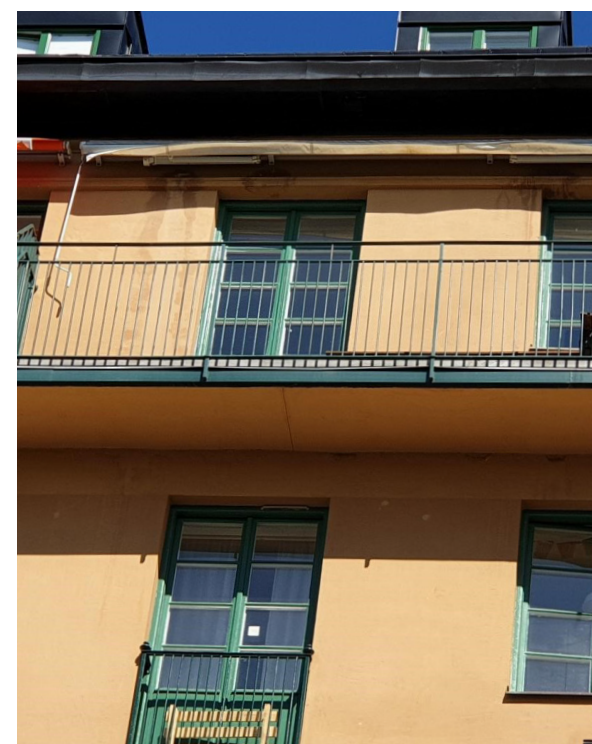
Plåttäckta balkongplattor (Skånegatan 79)
