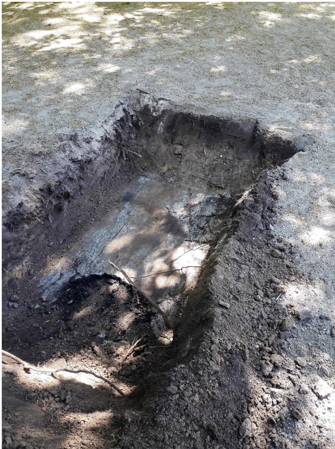
Bild 5: Asfaltslager från provpunkt 19W02, ca. 0,4–0,45 m u my.
