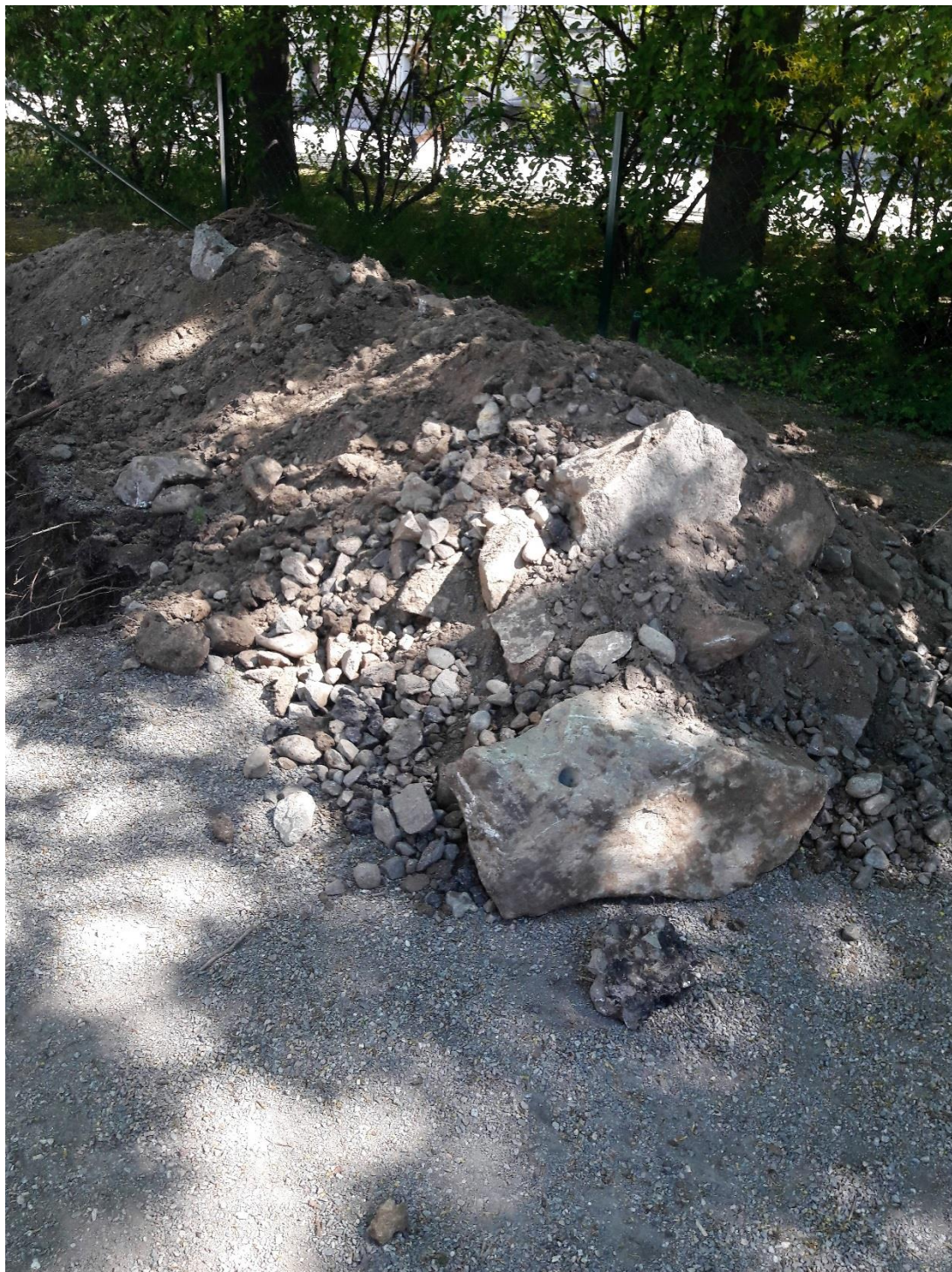
Bild 1: Schaktmassor från provpunkt 19W01.
