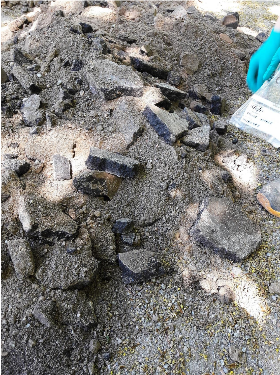
Bild 6: Asfaltsbitar från provpunkt 19W02, ca. 0,4–0,45 m u my.
