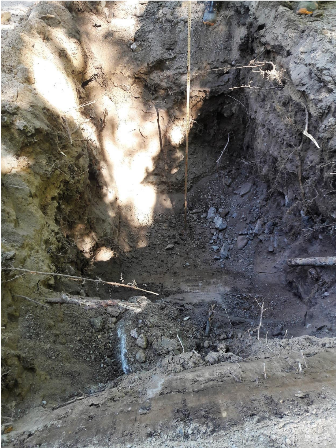
Bild 8: Schachtgrop från provpunkt 19W02.
