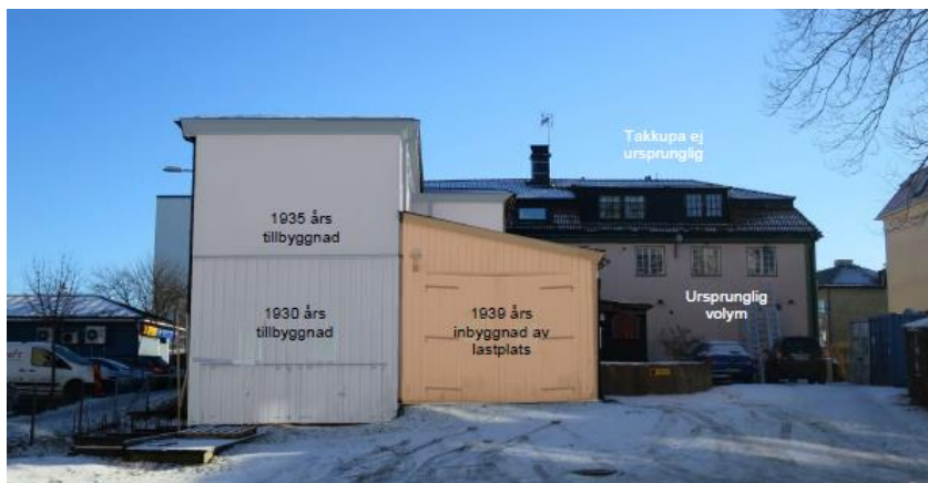
Spånga järn- och färghandels fasad mot nordväst
