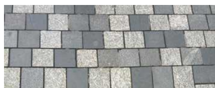
Frisens beläggning av smågatsten i olika grå nyanser (Nyréns Arkitektkontor).
