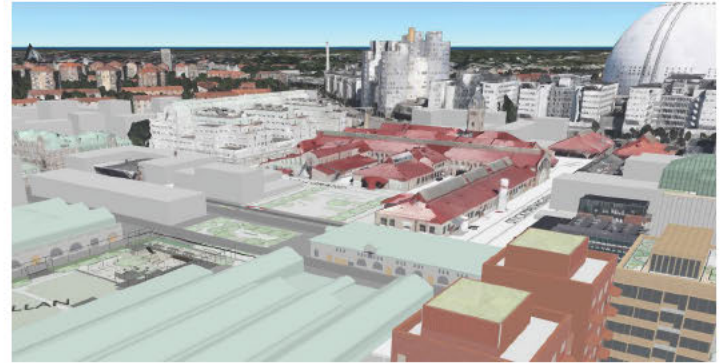
Flygvy som visar befintligt taklandskap och del av tillkommande tak i etapp 1 till höger i bild.
