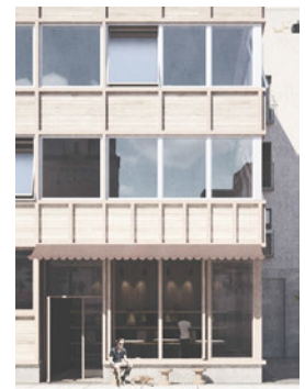
Träfasader med reliefverkan och fönsterband.
