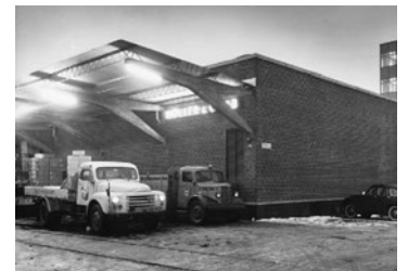
Skärmtak och sluten tegelvägg.
