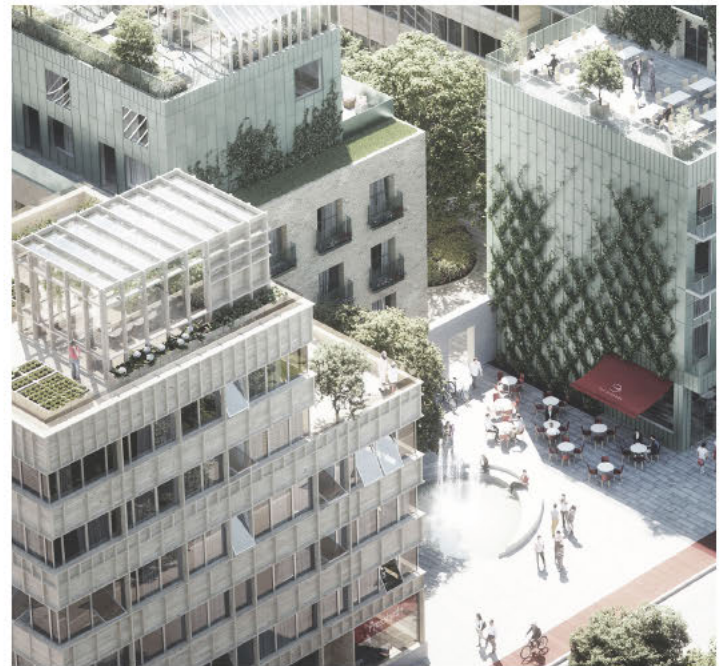
Tekniska utrymmen på takterrass får samutnyttjas med växthus eller gemensamhetslokaler. Bild: Kvarter M, AndréFogleström.
