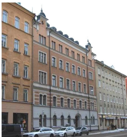
Fasaden mot Folkungagatan
