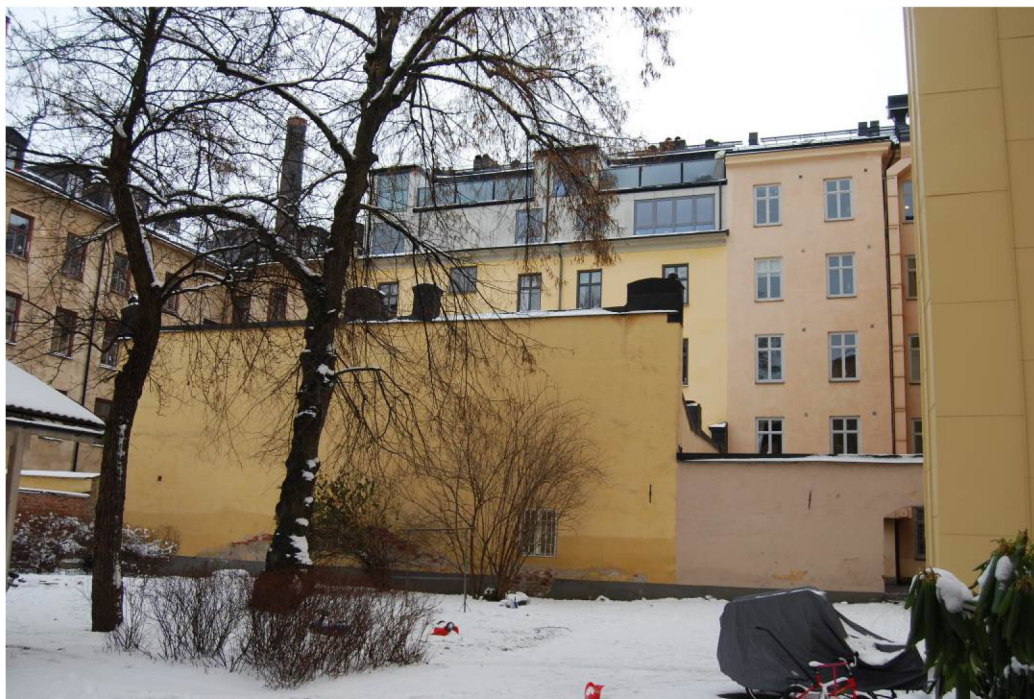
Nr 16, 17 med gårdshuset och 18. Längst till höger hissutbyggnaden i plåt till nr 19.
