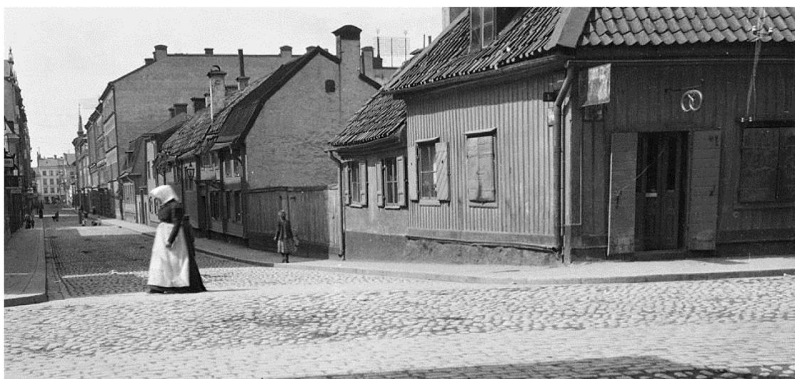
Under 1800-talets slut låg ännu många trähus kvar i kvarteren kring Folkungagatan. Kvarteret Båtsmannen, Kocksgatan västerut från Södermannagatan. Till höger Kocksgatan 29, längst bort i bild har stenhusen i kvarteret Båtsmannen 21 uppförts.
