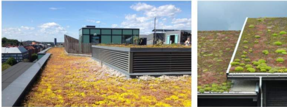
Figur 20. Exempel på olika typer av gröna tak, med en takträdgård till vänster och ett tunnare grönt tak till höger. Bild hämtad från SVOA:s anläggningsbeskrivning för vegetationsklädda tak.
