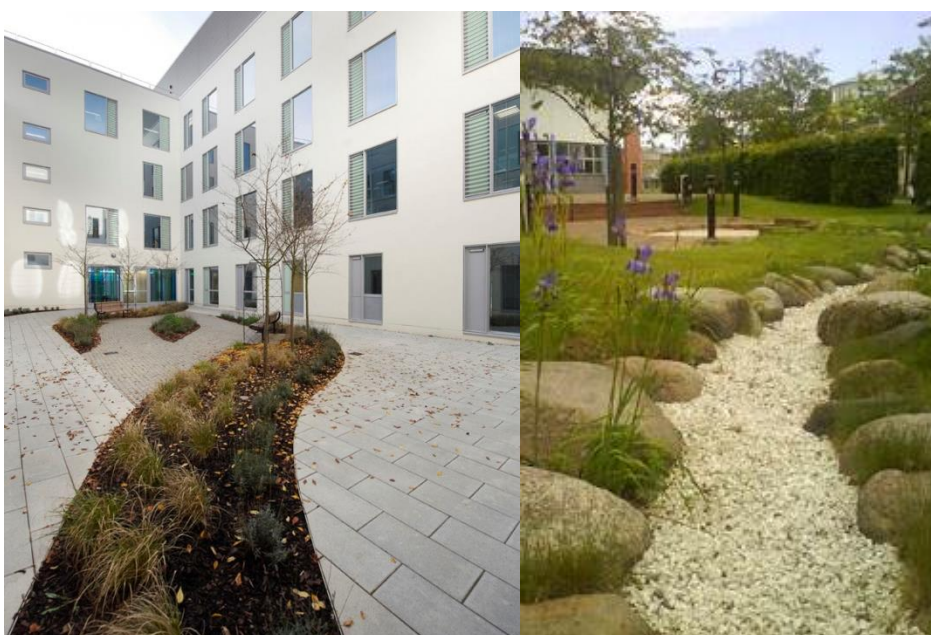
Figur 6. Exempel på stråk för fördröjning av dagvatten i form av växtbädd dragen genom gård med i övrigt hårdgjorda ytor och grusbädd med omgivande gräs – alternativt svackdike/lågstråk (Stockholm stad, 2015).
