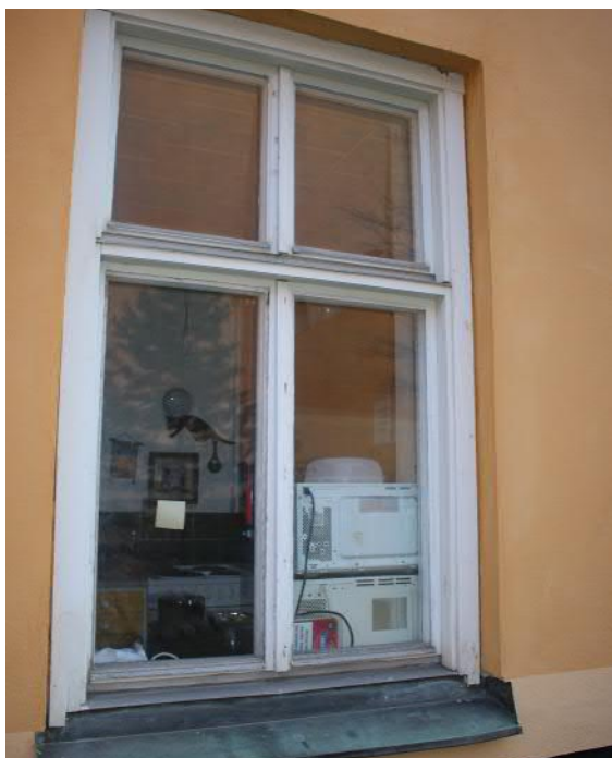
Samtliga av byggnadens fönster är sekundära och tillkom sannolikt på 1970-talet men har tidsenlig indelning med fast mitt- och tvärpost. Kopparblecken är ursprungliga/äldre.
