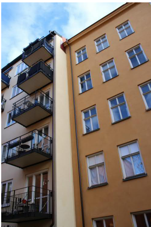
< Bergsgruvan Större 33 till vänster uppfört 1935-37 har utrustats med gårdsbalkonger under 2000-talet. Till höger syns gårdsfasaden för aktuell fastighet som enligt förslaget ska utformas med balkonger.
