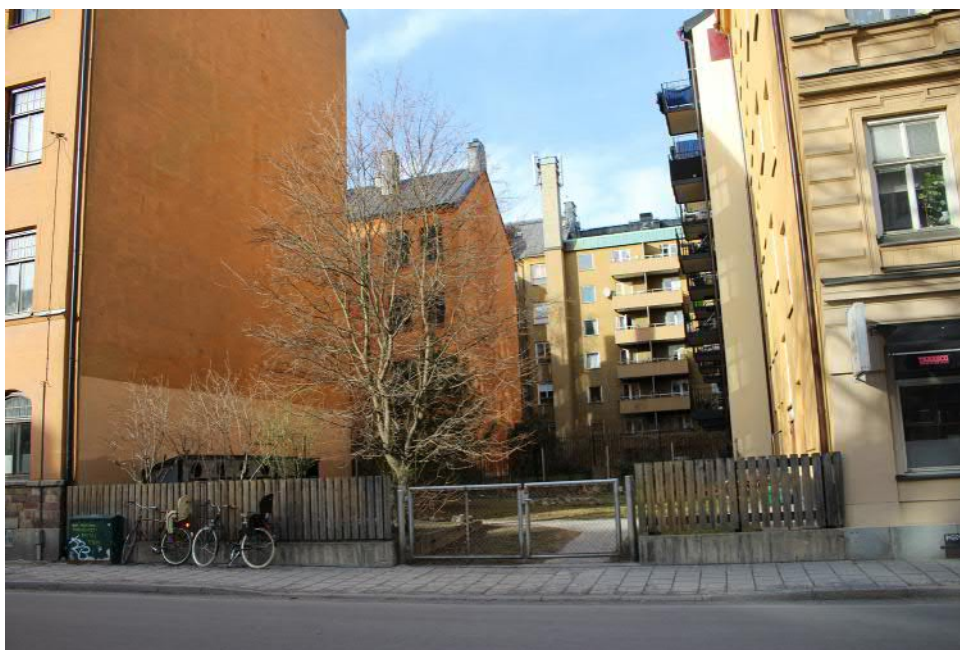
Gården sett från Höbergsgatan.
