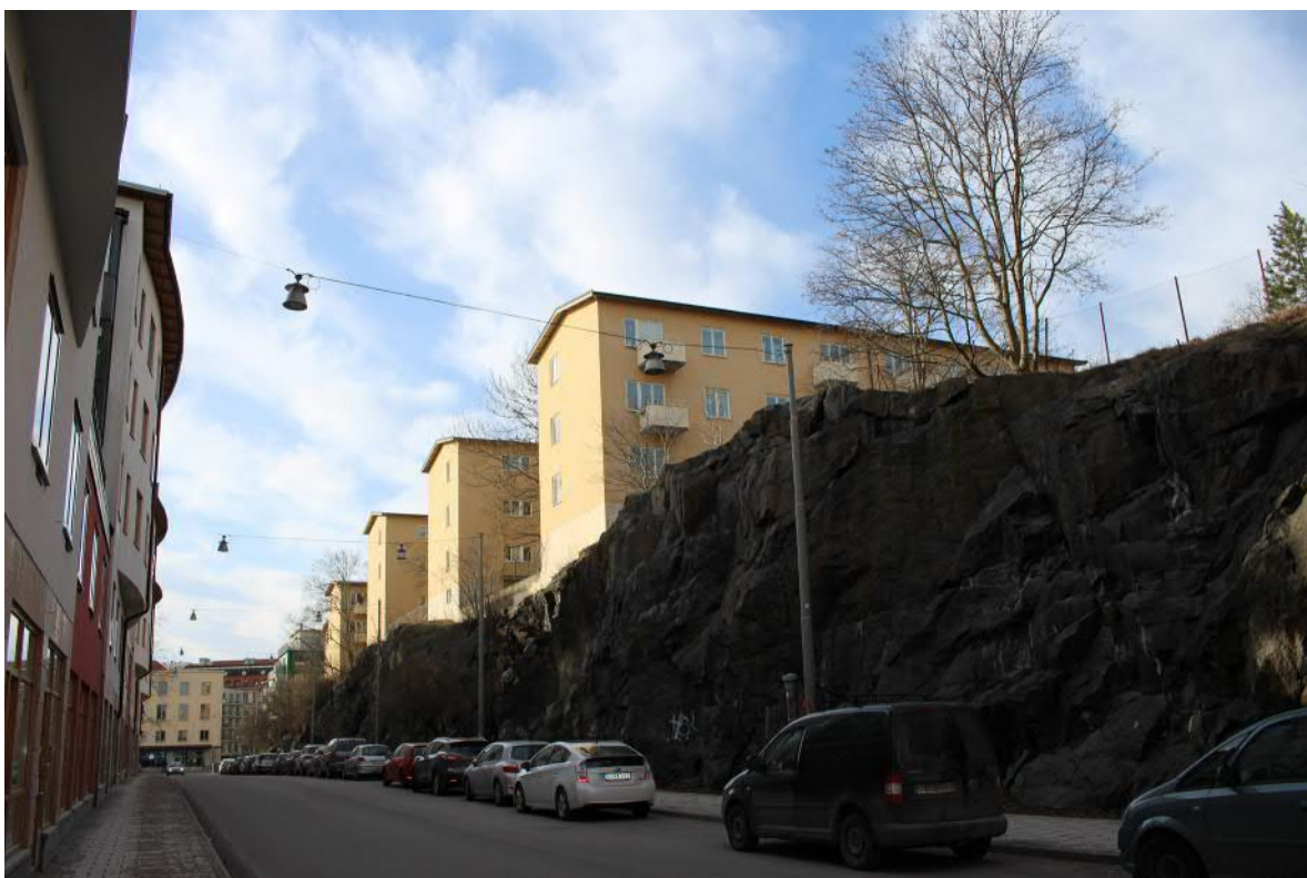
Sydvästra delen av kvarteret med 1930-talslameller i fyra våningsplan belägna på den sparade bergsplatån. Husen är parallellt placerade med gavlarna vända mot Högbergsgatan.
