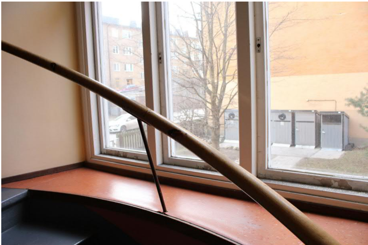
Fönsternisch i trapphus. Trapphusfönster är sekundära och fönsterbänk har klätts in med plastmatta.
