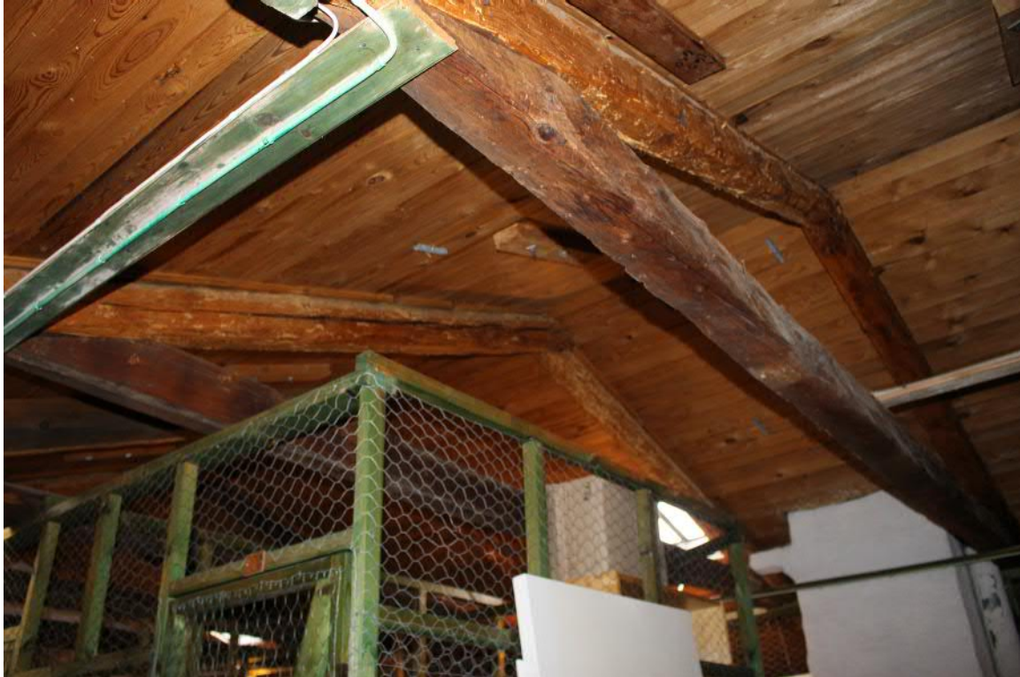
Takstol och takpanel är exponerad på vinden.
