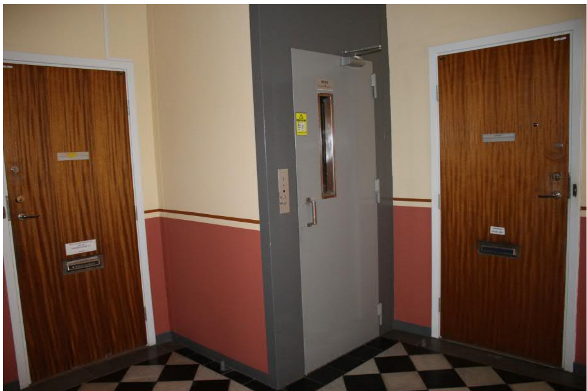
I Trapphusplanen finns ursprungligt rutigt stengolv med fris. Tamburöddörrar är utbytta till fanérklädda dörrar med enkla, släta dörrfoder, sannolikt på 1960-70-tal. Hissen installerades på 1970-talet.
