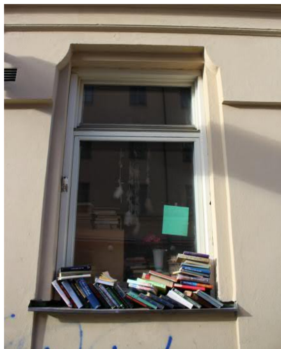
Fönster i bottenvåningen har bytts ut till tvåluftsfönster utan mittpost och spröjs. Fönsternischens insvängda form i övre delen är sannolikt formad efter de putspilast-rar som ursprungligen smyckade entréfasaden.
