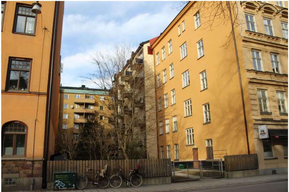
Gården omges av ett trästaket och stålgrind mot Högbergsgatan.
