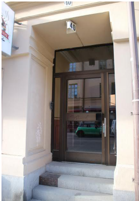
Entré till trapphus från Timmermangatan. En glasad aluminiumport har ersatt ursprunglig träport. Trappa i granit.
