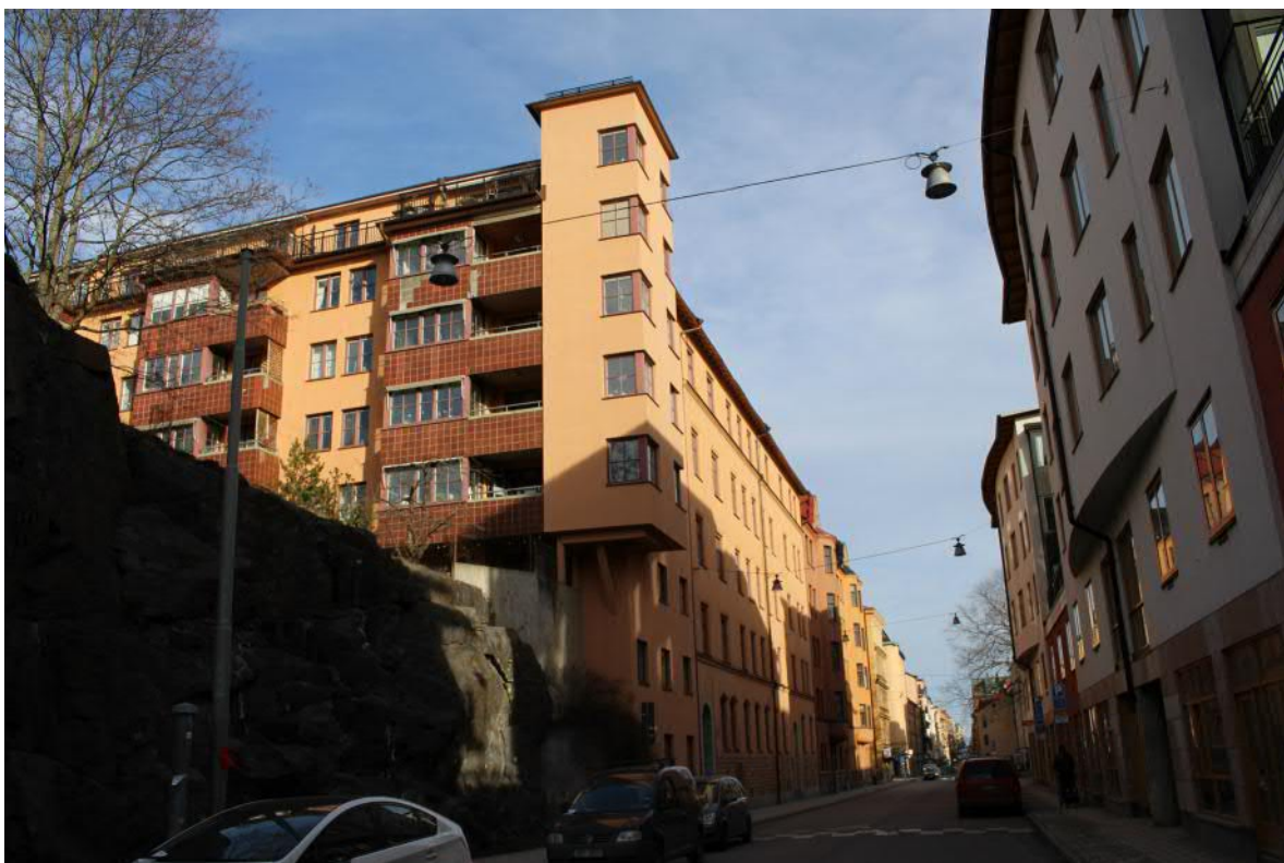
Bergsgruvan Större 39 från 1903-04 med tillbyggd del mot väster från 1980-talet. Det rektangulära hörntornet höjer sig ovan resterande takfotslinje. I förgrunden till vänster syns del av den bergsplatå som tar vid i kvarterets sydvästra del.
