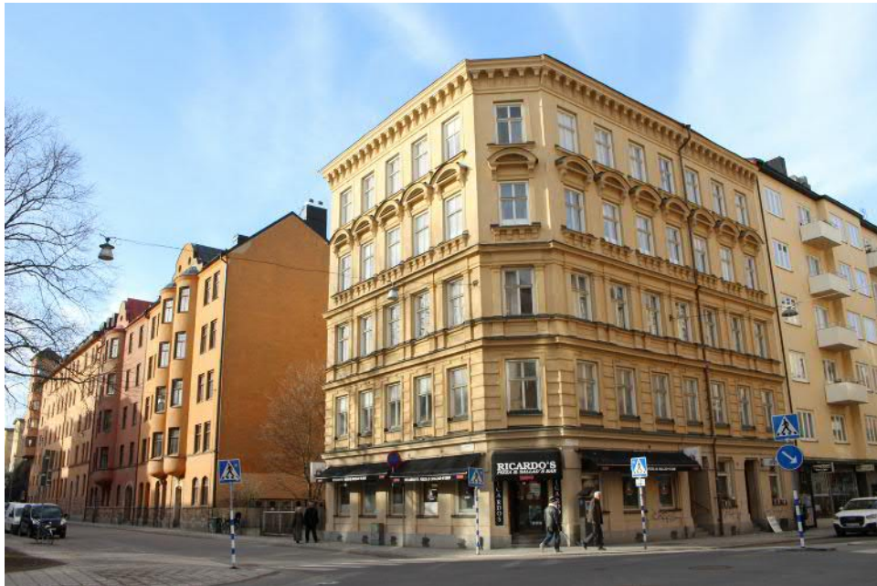
Fasaden mot korsningen Högbergsgatan-Timmermansgatan. Taket är knappt synligt från denna vyn.
