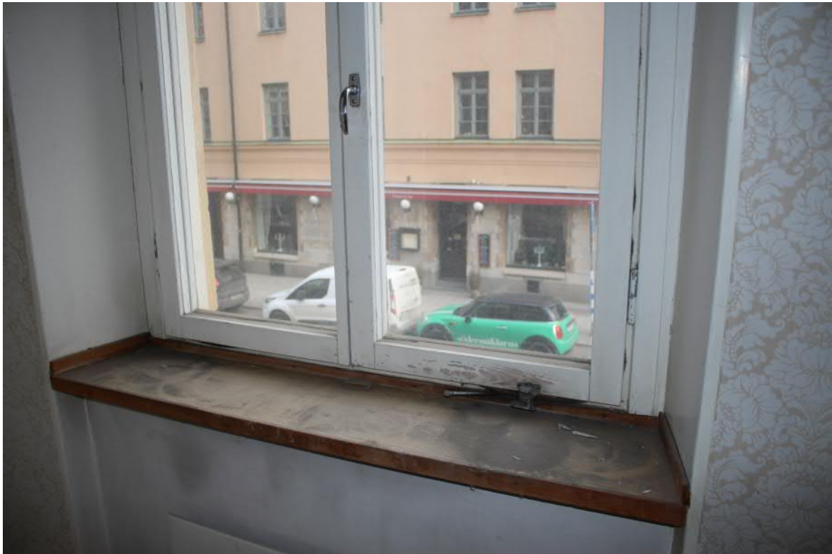
Sekundärt träfönster och beslagning. Fönsterbänkar är inklädda i träfanér.
