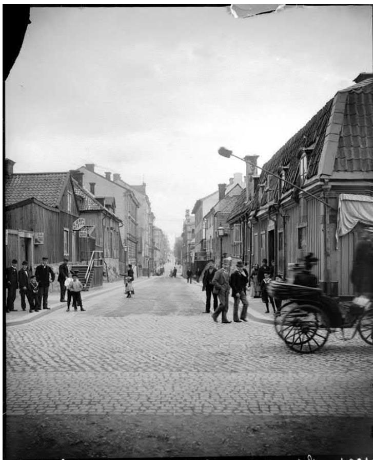
< Timmermansgatan Högbergsgatan österut 1896. Småskalig trä- och stenhusbebyggelse och gatsten.
