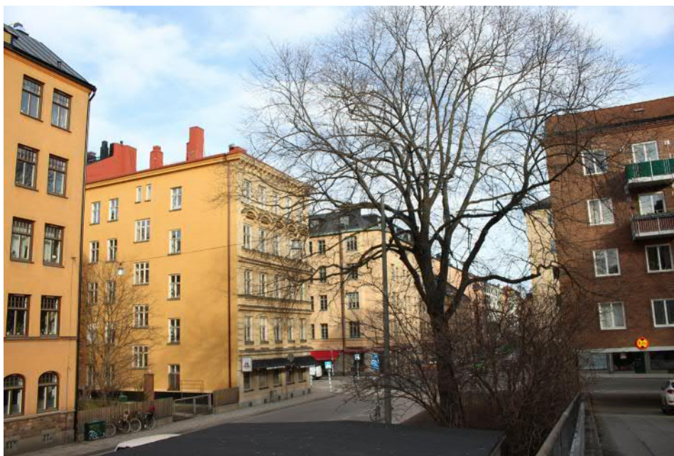
Byggnaden från Högborgsbacken från sydväst.
