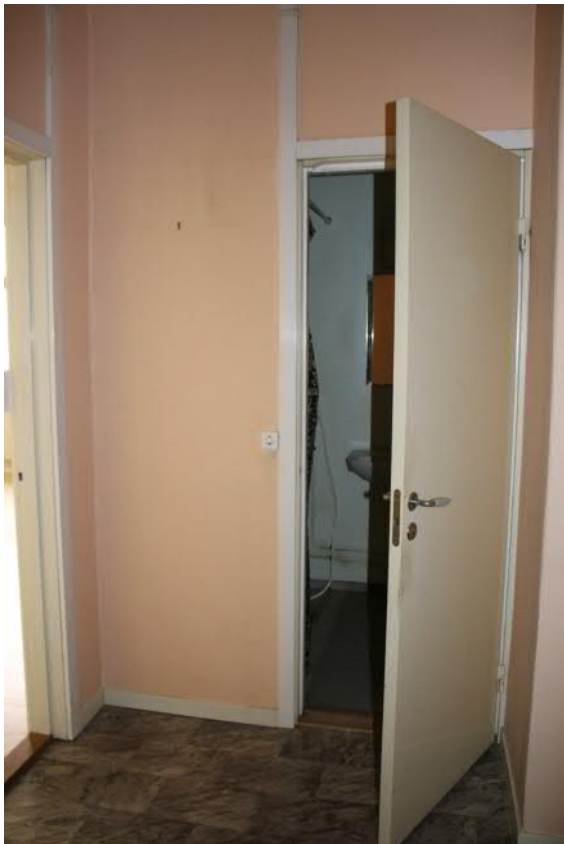
Hall med sekundära ytskikt, dörr och snickerier.
