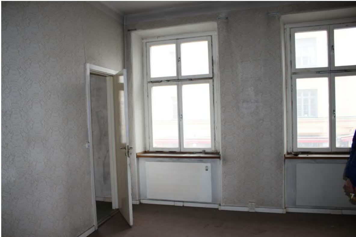
Lägenhet mot Timmermansgatan. Fönster, fönsterbänkar, dörrar, lister, ytskikt och elradiatorer är från 1970-talet
