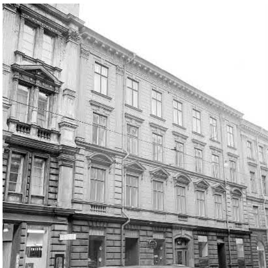
< Exempel på byggnad ritad av Carl Cederström är Laxöringen 1 på Sibyllegatan i Stockholm, uppförd 1881-82. Foto från 1961. Stadsmuseet.
