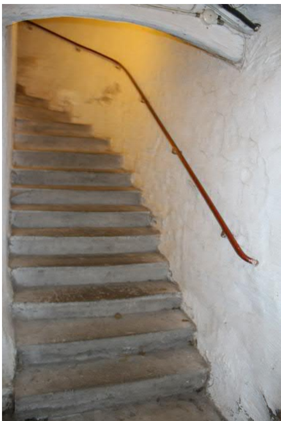
Ursprunglig källartrappa med trappledare i trä.
