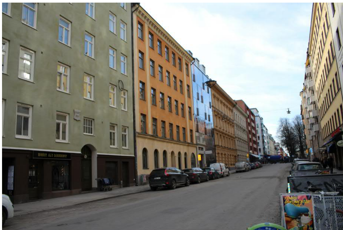
Wolmar Yxkullsgatan österut. Mellan de klassicistiska stenstadsfasaderna har ett infill-hus med helglasad fasad adderats under 2010-talet. Den glasade fasaden utgör ett skal framför den äldre fasaden som finns kvar bakom. Taket är flackt men har höga takkupor som sticker upp ovan resterande takfotslinje.
