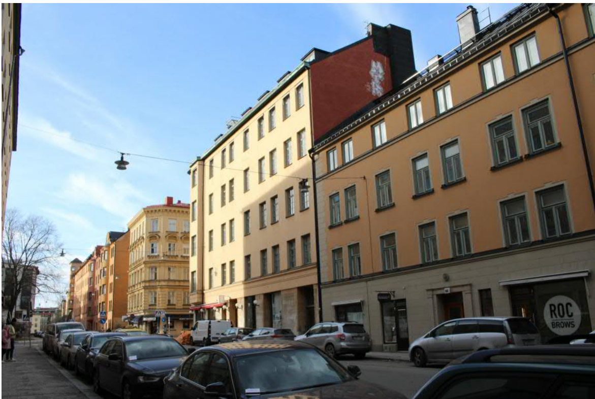
Högbergsgatan västerut. Hörnhuset i Bergsgruvan större 9 med intilliggande jugendhus inom Bergsgruvan Större 37-38 syns efter korsningen till höger. Tomrummet mellan fastigheterna visar sig genom den synliga brandgaveln tillhörande jugendhusets fasad.
