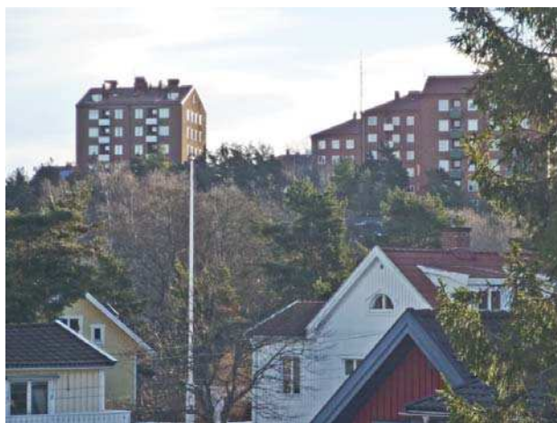
Från Hägerstens villabebyggelse bildar punkthuset i norr en tydlig siluett över hustaken.
