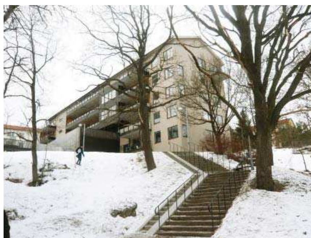
Nyttillkomna uppskalade volymer vid Lotterivägen där husen på ytersidorna möter befintlig naturmark, men får en avskalad utemiljö, med höga stödmurar, överdäckade gårdar och branta slänter, som bryter mot rådande karaktär. Exemplet belyser problematiken för nya etableringar i Hägerstensåsen, där husen knuffas framåt i slänterna och alltmer branta lägen tas i anspråk.
