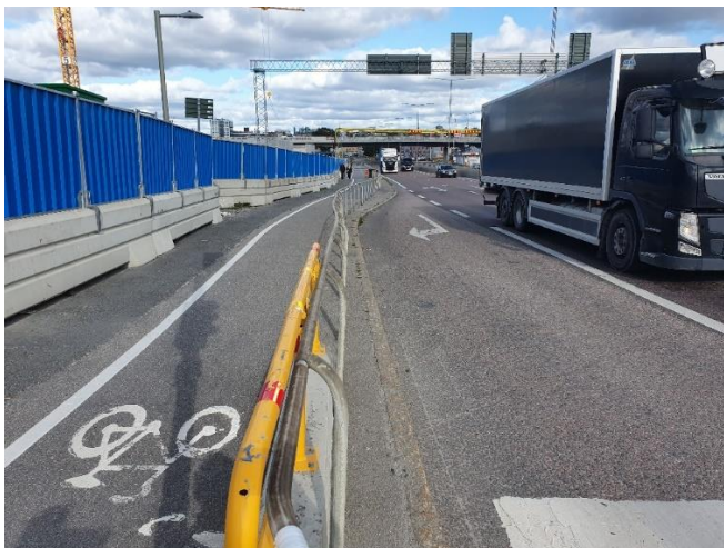
Figur 10. Ulvsundavägen, utformning vägkant och avkörningsskydd/vägräcke.
