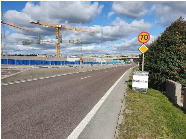
Figur 9. Ulvsundavägen förbi planområdet. Hangar (H5) med byggarbetsplats längst bort i bild.
