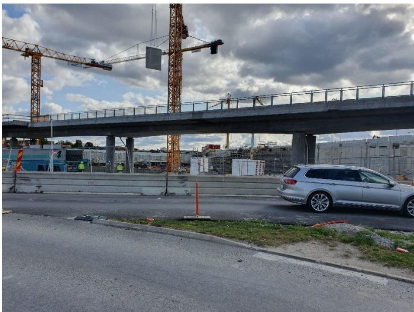
Figur 13. Tvärbanans Kistagren på bro genom planområdet. Byggnationen pågår.
