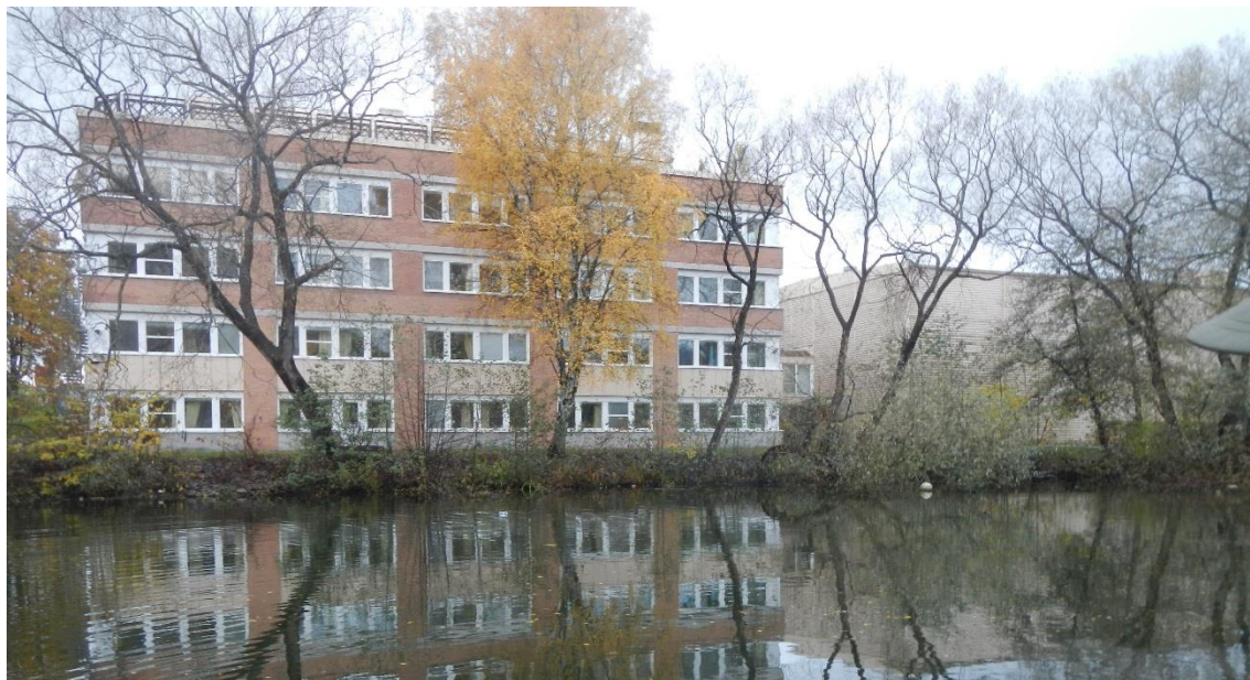
Figur 21. Stranden inom delsträcka 1 består av utfyllnad med sprängsten bevuxen av en smal trädbård.
