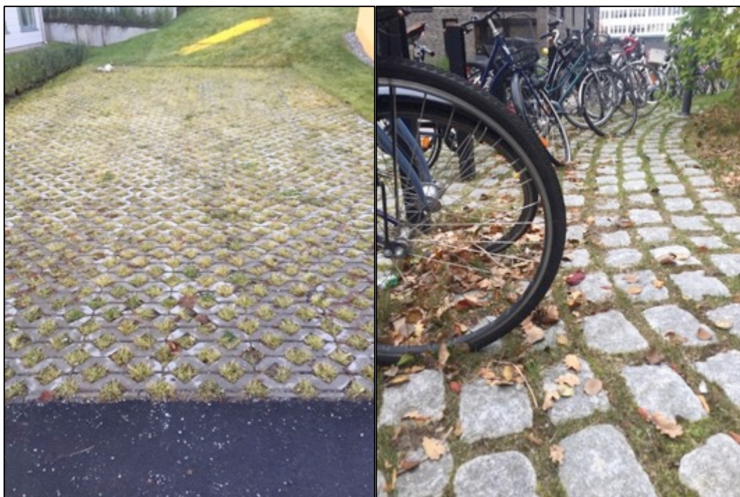
Figur 8. Till vänster: yta belagd med rastersten. Till höger: cykelparkering belagd med marksten. Dagvatten kan infiltreras i fogarna mellan stenarna. Foto Geoveta
