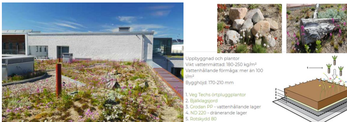
Figur 11. Exempel på strandängs-biotoptak från fastigheten Koggen i Malmö (foto: Grönatakhdboken) samt möjlig uppbyggnad (illustration: Vegtech).
