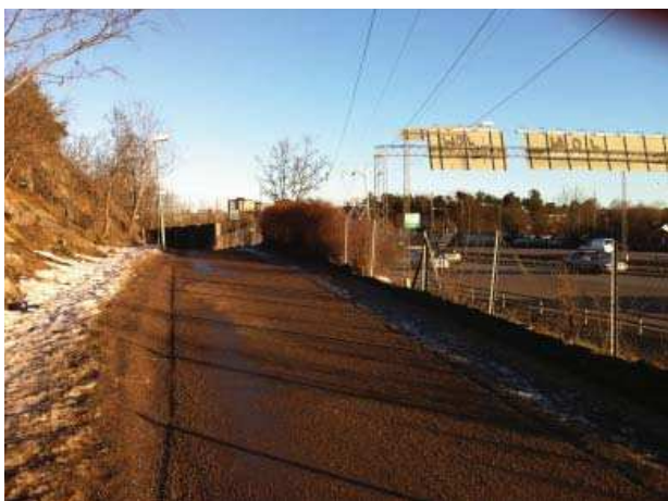
Södertäljevägen utgör en barriär mot stadsdelarna söderut. Bullerplanket vid Hökmossen slutar strax före åsen. Ett regionalt cykelstråk löper parallellt med motorvägen och den södra åskanten.
