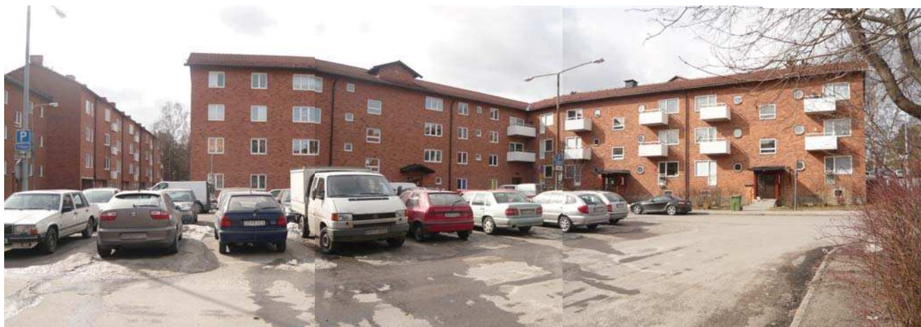
Platsbildningen för det tidigare Konsumtorget används idag som boendeparkering. Många passerar här, antingen till och från Inteckningsvägen, eller längs med Mellanbergsvägen.
