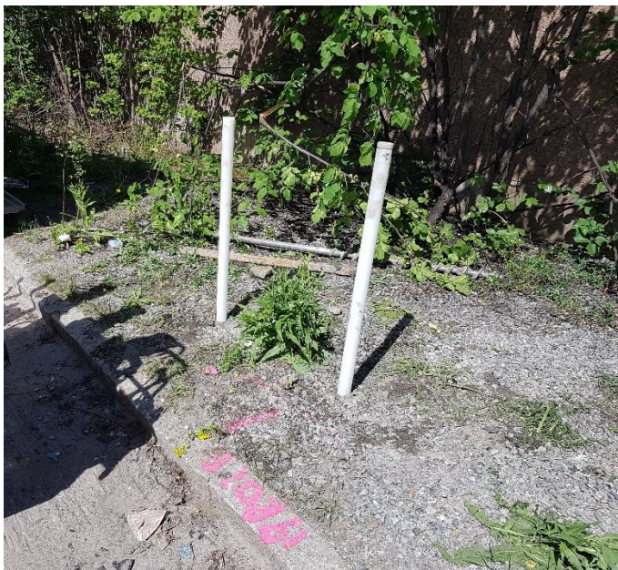
Figur 7. Installerade grundvattenrör i provtagningspunkt 19R02.
