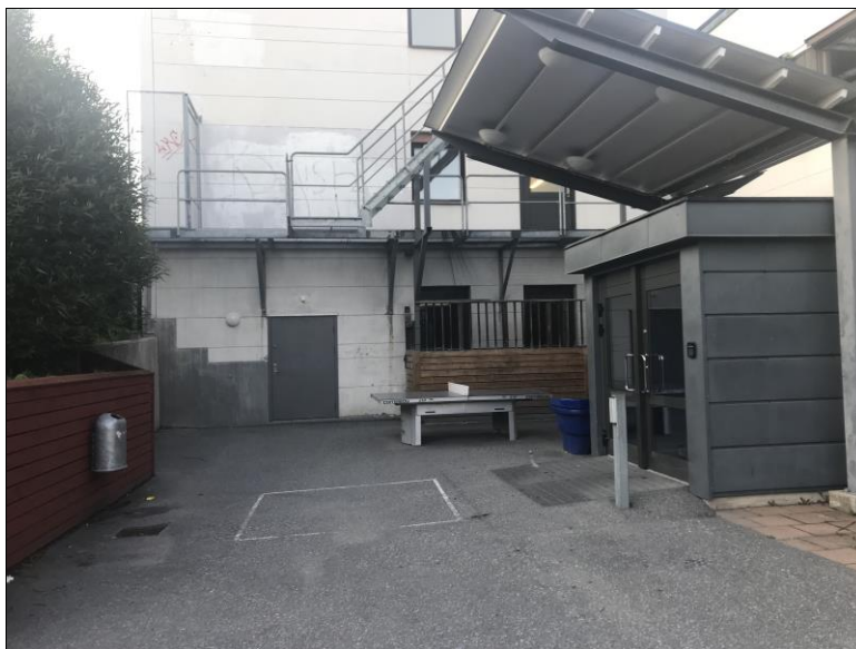
Figur 9. Inre del av fastighetens innergård där hårdgjorda ytor sluttar mot dagvattenbrunn.
