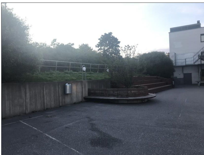
Figur 10. Gröna slänter som är med sluttning in mot fastighetens innergård.
