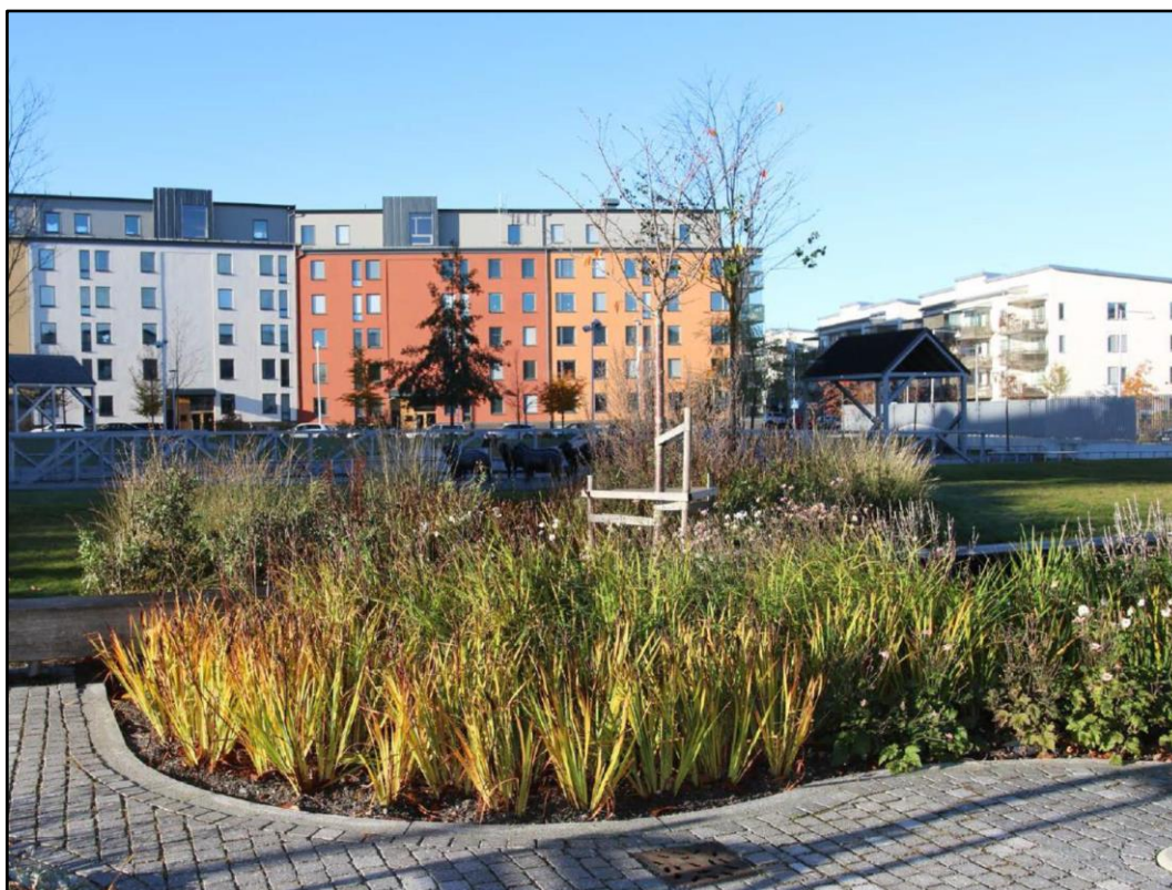
Figur 17. Exempel på nedsänkt växtbädd (Solna stad dagvattenstrategi, 2019).
