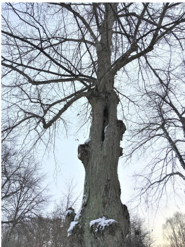
Bild 28 En större stamskada vid ca 5 m
