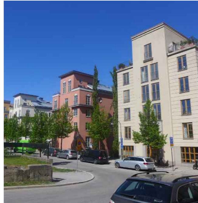
Bostadsbebyggelse i kv. Grubbens längs gatans norra sida.
