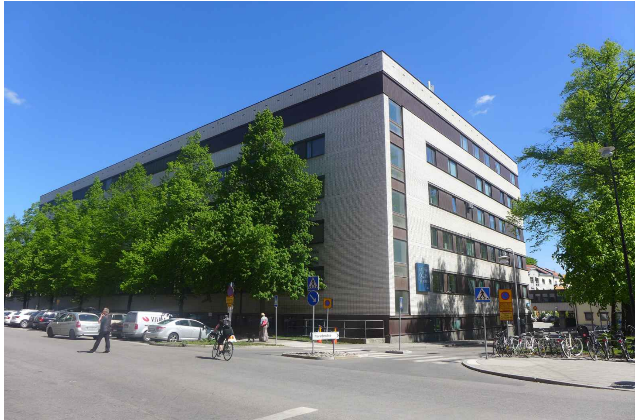
Sjukhusbyggnaden sedd från korsningen Polhemsgatan - Fleminggatan. Arkitekturen mot Polhemsgatan ter sig sluten och bidrar till att gatusträckan upplevs som stängd.
