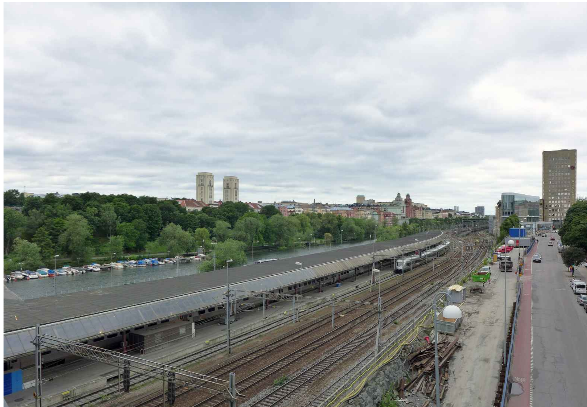
Vy från Barnhusbron i riktning mot fastigheten. Spårområdet karga landskap står i skarp kontrast till den lummiga miljön kring Barnhusviken. 2017-07-04.
