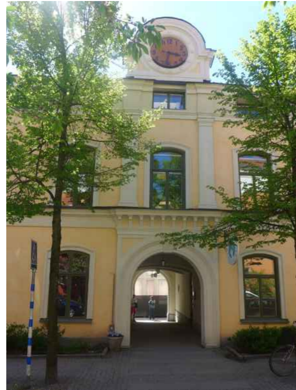
Portalbyggnaden är med passage till Fleminggatan är den portvaksbyggnad som uppfördes vid Grubbens.
