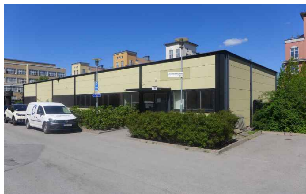
Den f.d. värmecentralen i fastighetens norra del står idag oanvänd. Den omges av informell växtlighet och markparkering.
