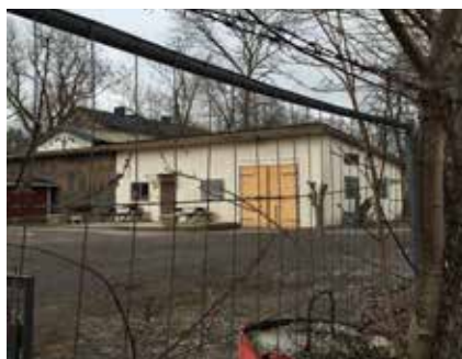
Fig. 22: Verkstadsbyggnad inom planområdet.
