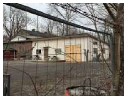
Fig. 36: Verkstadsbyggnad inom planområdet.
