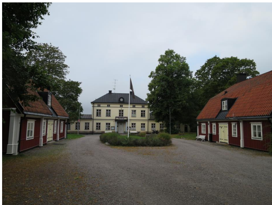
Foto till höger: huvudbyggnaden. Foto till vänster: ekonomibyggnader. Foton: Nivå landskapsarkitektur
