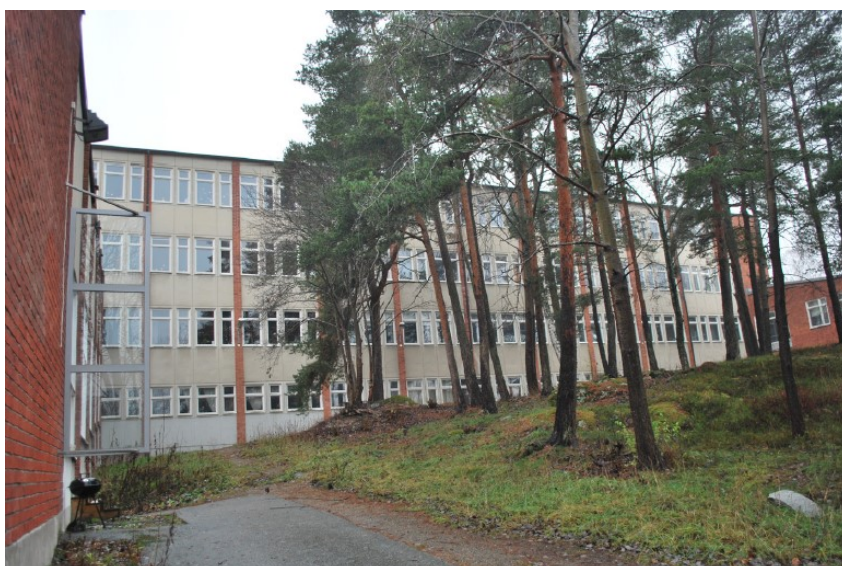
Figur 6. Den f d skolbyggnadens fasad mot Örbyleden. Bild: Tyréns (från bilagd kulturmiljöanalys)
