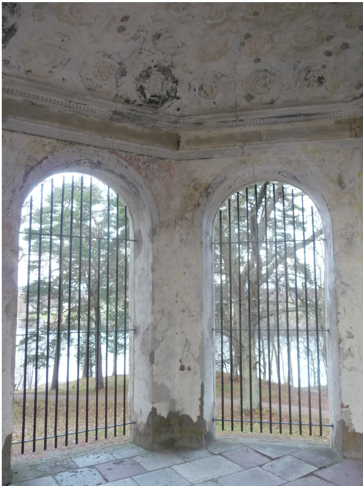
Överblick över putsade och dekormålade väggar, Sentida putslagningar i cementhaltigt bruk i anslutning till stengolv. Cementputs bör avlägsnas och putsas med hydrauliskt kalkbruk.
