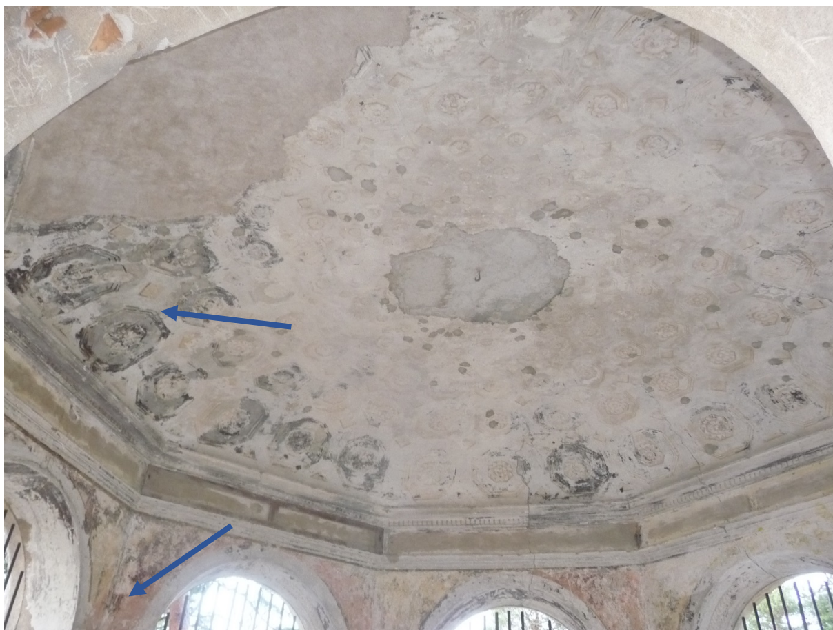
Förslag på ytor att säkra och rekonstruera av konservator, se pilmarkeringar.
