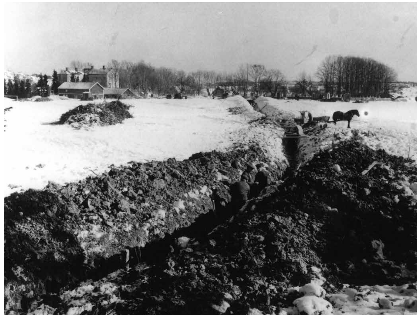
Bromma Hembygdsförening, Bällsta gård: 020, foto uu. Dränering inför bygget av villastaden. Kring norra delen av tomten har en rad granar planterats, som vindskydd eller insynskydd? Träden i raden norr om västra trädgården verkar vara av blandade arter, lönn, alm och ask.
