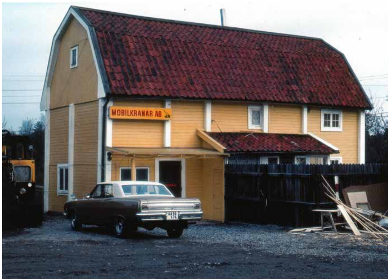
Bromma hembygdskommitté, Bällsta gård: B-014 dia, foto uu. F.d. förvaltarbostaden i östra trädgården har här övergått till att bli kontor för en firma som hyrde ut maskiner. Byggnaden restaurerades 1973. Så sent som 1976 stack snödroppar fortfarande upp intill huset.
