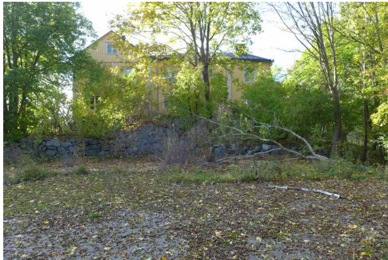
Från öster. Till höger den stora norra flygeln som byggdes till 1857 då övervåningen byggdes på.
