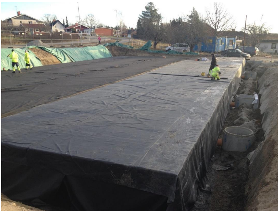
Figur 17 Anläggning av fördröjningsmagasin med plastkassetter
