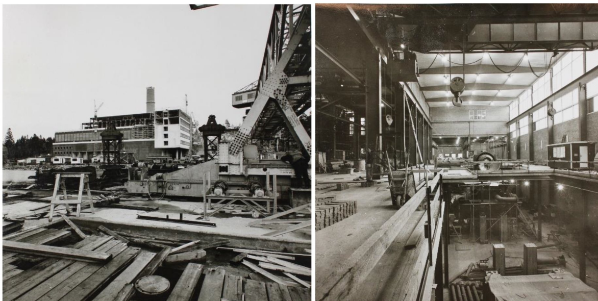
Hässelbyverket under uppbyggnad. Till vänster syns fotografi från hamnbassängen med vy mot kraftverksbyggnaden och kontorshuset. Till höger syns turbinhallen med öppningar i bjälklaget för ångturbinerna. Källa SSA
