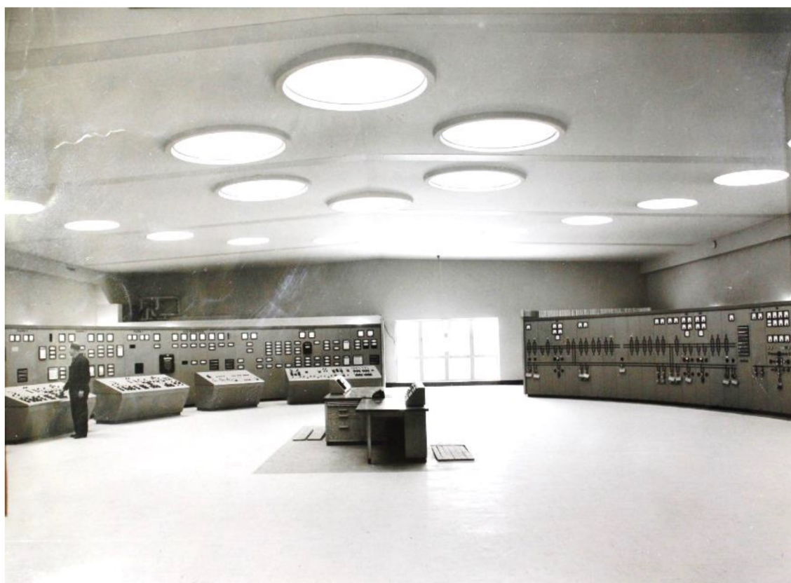
Kontrollrummet i sin ursprungliga skepnad med taklanterniner som följer rummets form. Källa SSA
