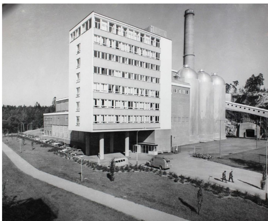
Fotografiet från tidigt 1960-tal visar anläggningens ursprungliga karaktär. Förändringar har framförallt skett av kraftverksbyggnadens planform, entréhallen i kontorsbyggnaden samt uppförandet av verkstaden som vid fototillfället ännu inte byggts. Källa SSA.
