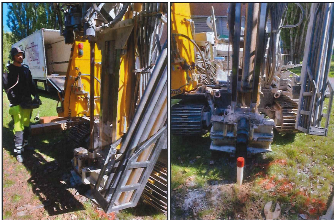
Figur 5. Installation av Gv03 vid Kraftverksområdet vid Hässelbyverket.
