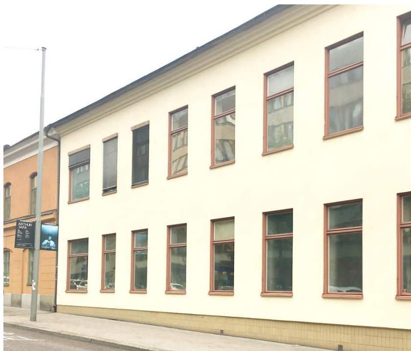
Röntgenbyggnadens nuvarande kulör och fönstersättning.
