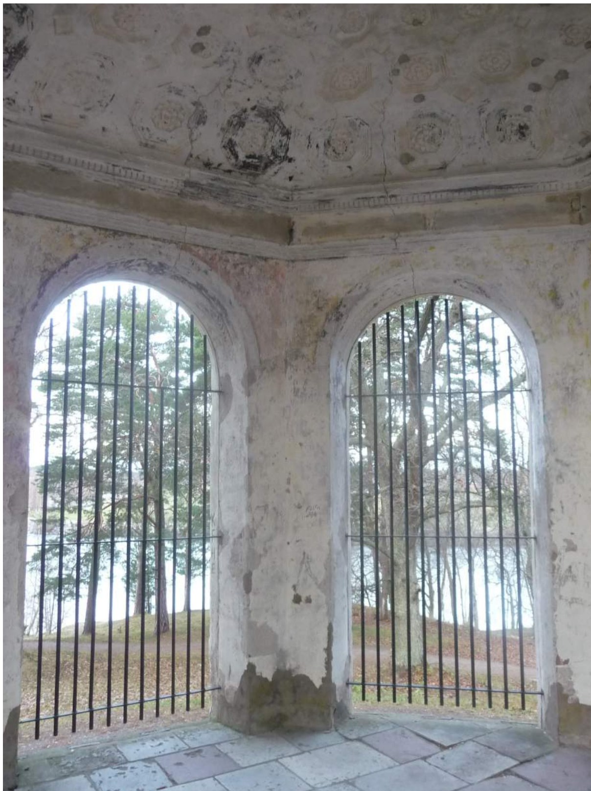
Överblick över putsade och dekormålade väggar, Sentida putslagningar i cementhaltigt bruk i anslutning till stengolv. Cementputs bör avlägnas och putsas med hydrauliskt kalkbruk.
